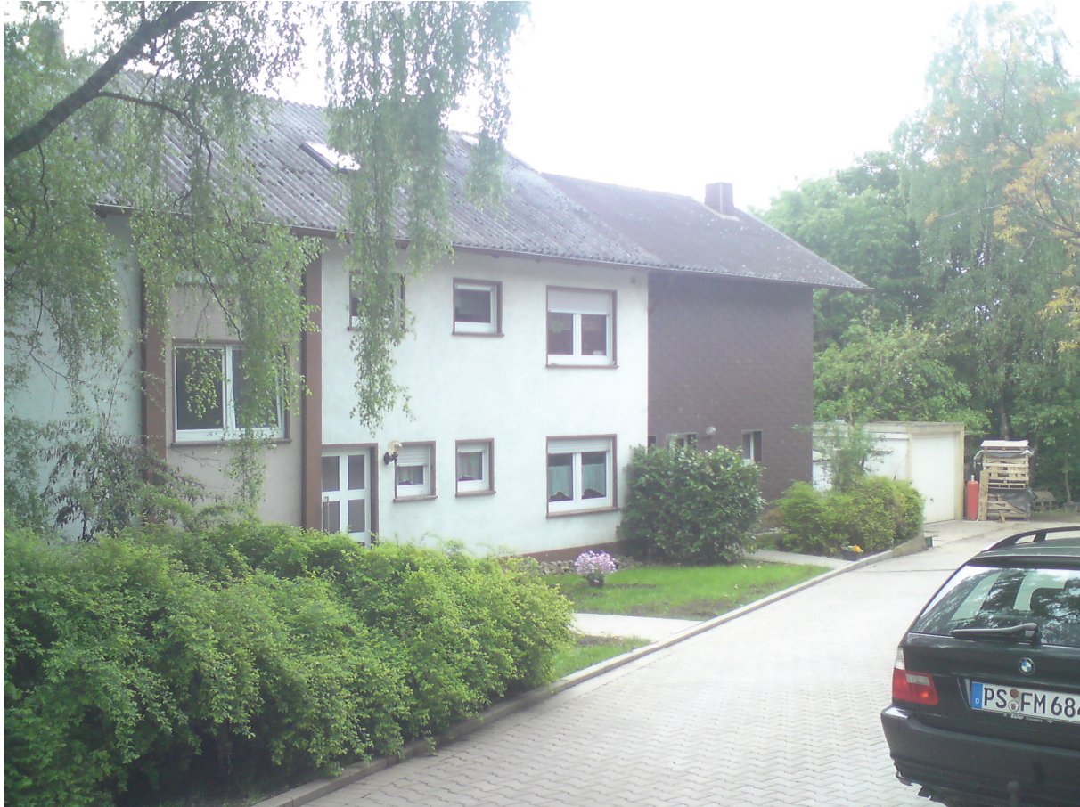
Abb. 12: Altes Wohnhaus (Quelle: Naruhn, 2010)
