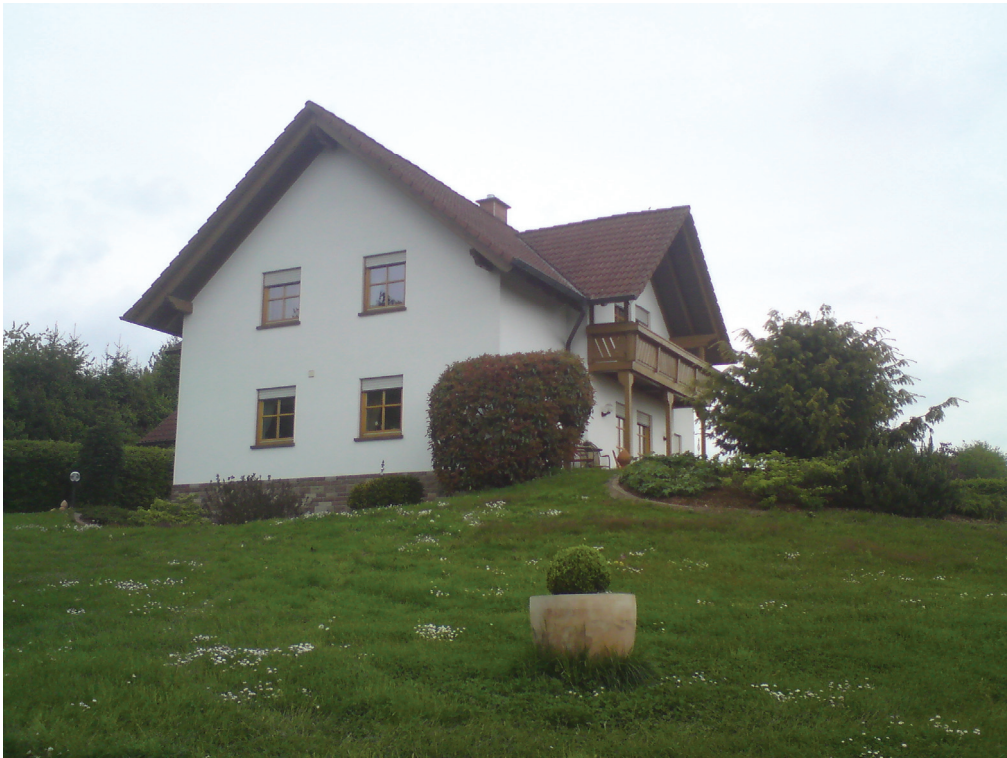
Abb. 18: Neues Wohnhaus (Quelle: Naruhn, 2010)
