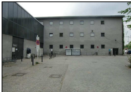
ABB. 53 VERSPERRTE SICHT ZUM ERNST-REUTER-PLATZ DURCH DAS GEBÄUDE FÜR BERGBAU UND HÜTTENWESEN
