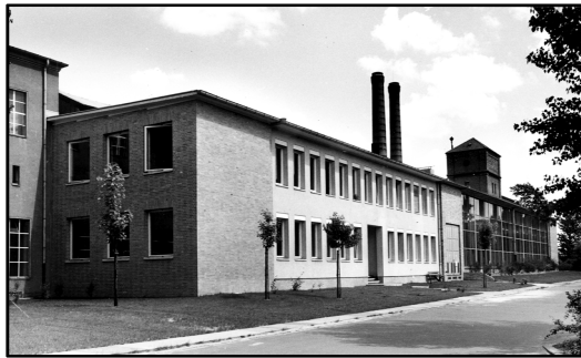
ABB. 16 1950 GEHWEG AM GEBÄUDE FÜR THERMODYNAMIK UND KÄLTETECHNIK
