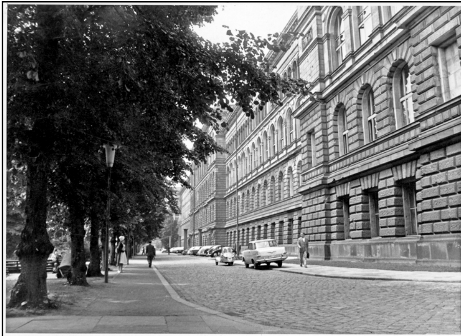
ABB. 14 1950/1960 GEHWEG AN DER STRAÙE HINTER DEM HG MIT EINER WASSERGEBUNDENEN WEGEDECKE
