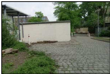
ABB. 41 FLACHBAU VOR EHEM. TORZUFAHRT
