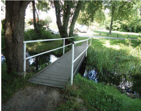
Abb.21: Brücke zur Halbinsel
