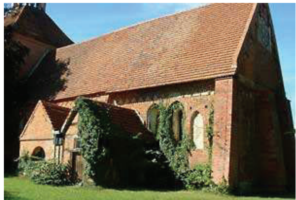
Abbildung 6: Kirche im Ortsteil Schorrentin
