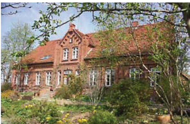
Abbildung 5: Pfarrhaus im Ortsteil Schorrentin
