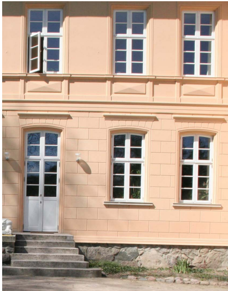
Abb. 59: Fassade mit Fenster und Bossen Nutplatten
