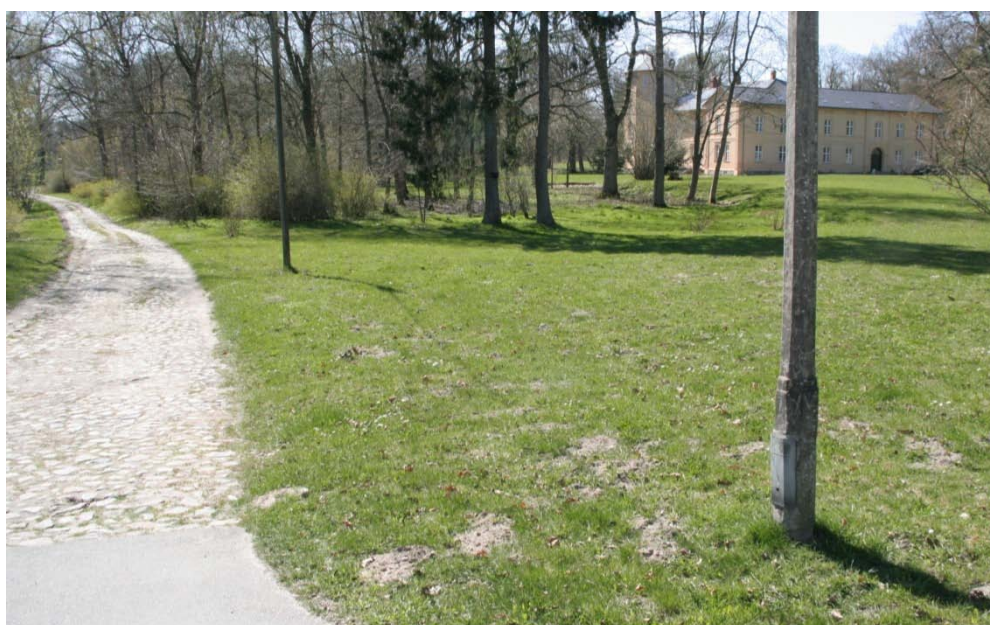
Abb. 94: ehemalige Zufahrt, Kopfsteinpflaster
