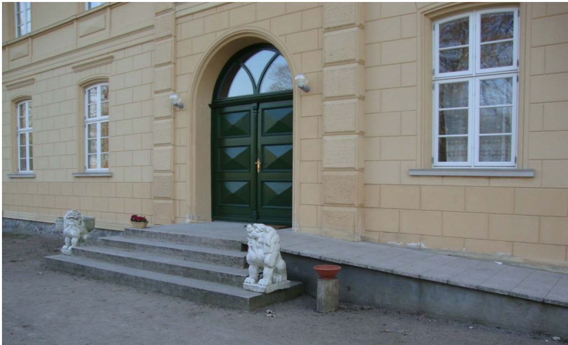
Abb. 60: heutiger Haupteingang mit Treppe aus Blockstufen, Löwenskulpturen
