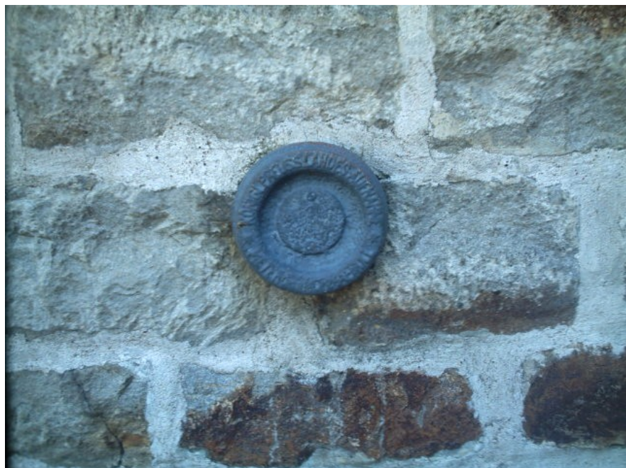
Abb. 25: Nivellementpunkt an der St. Alexander Kirche in Wallenhorst
