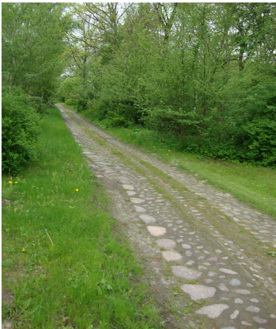
Abb. 93: ehemalige Zufahrt, Kopfsteinpflaster
