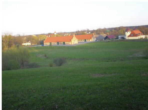
Ehemalige Scheunen (1851/52), heute Wirtschaftsgebäude der Agrar GmbH & Co. KG
