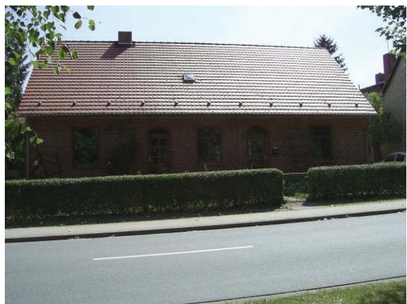
Schloßstraße, historisches Wohngebäude (1864)
