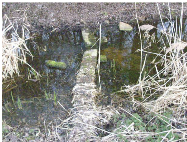
Abb. 4.3-2 – Tauchwand Verbindungsgraben Schäfersteich-Dröbel, westlich des Schäfersteiches, 2010
