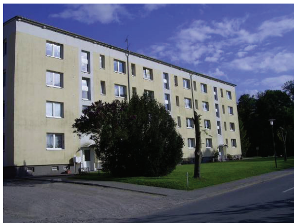
Schloßstraße, Neubau 24 WE
