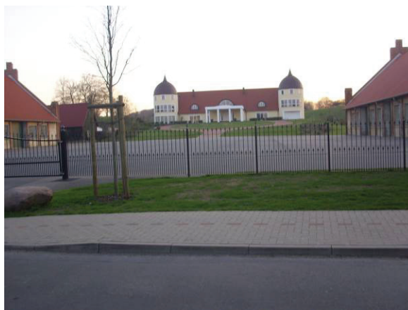
Wargentiner Straße, neues Gästehaus hinter den ehem. Scheunen des Wirtschaftshofes
