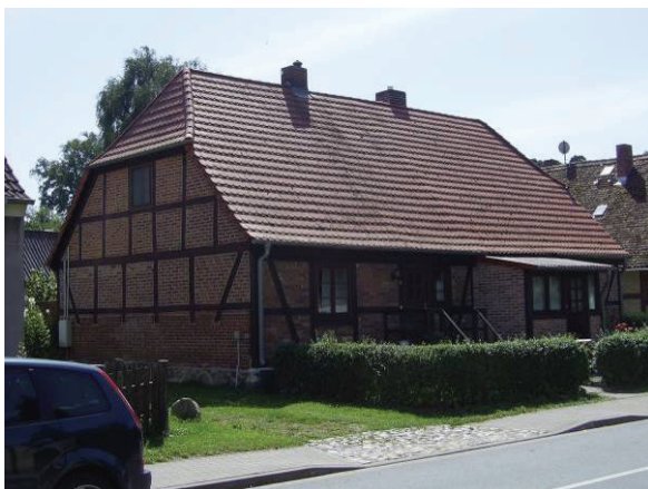
Schloßstraße, historisches Wohngebäude (1843)
