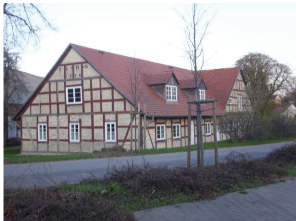
Wargentiner Straße, ehem. Landhaus (1842)
