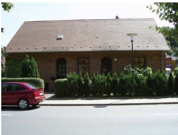
Schloßstraße, historisches Wohngebäude (1865)
