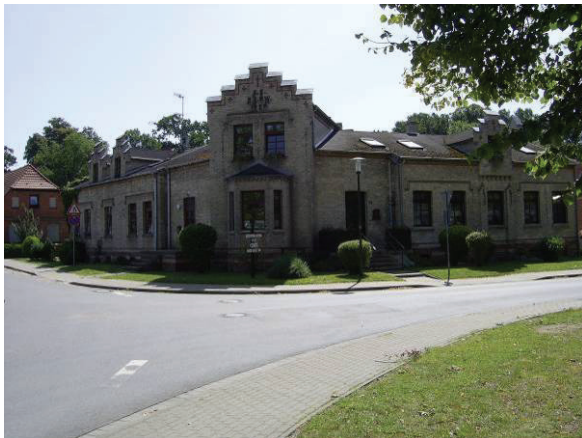
Schloßstraße, ehem. Gasthaus (1889), heute Wohnungen
