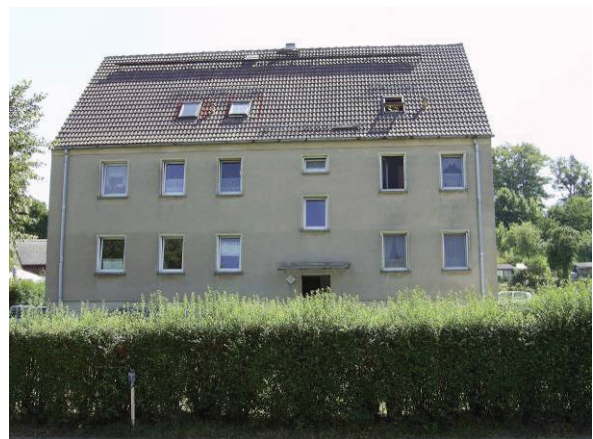
Schloßstraße, Neubau 8 WE
