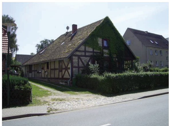
Schloßstraße, historisches Wohngebäude (1844)
