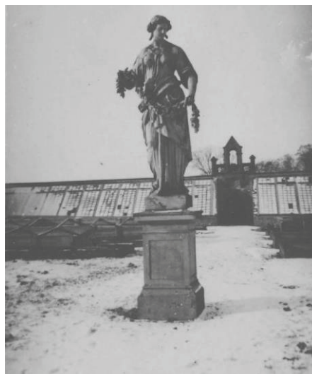
Abb. 4.5-2 – Gewächshaus nördlich im Küchengarten, heute nur noch in Mauerresten erhalten, Anfang 1970er Jahre (Fotoarchiv Landschaftsarchitekturbüro Pulkenat)
