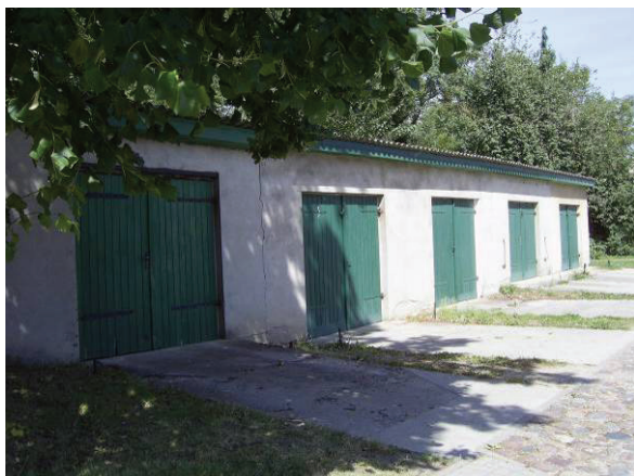
Schloßstraße, Garagen südwestlich der Kirche
