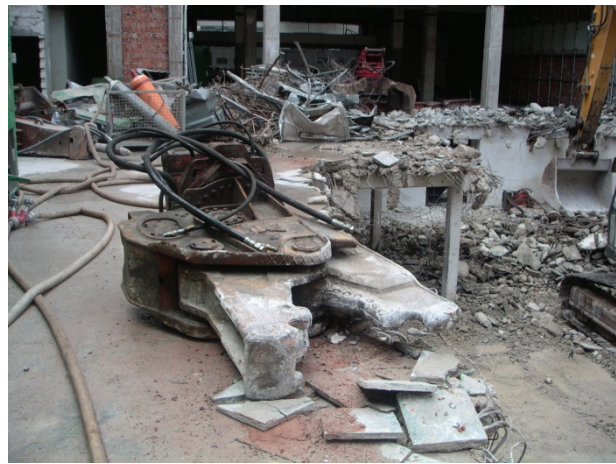
Abb.3 und 4: Abrissbagger vom Dach aus gesehen und Kneifzange(eigene Bilder)
