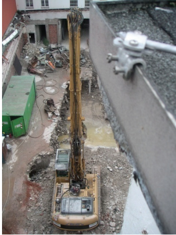
Abb.3 und 4: Abrissbagger vom Dach aus gesehen und Kneifzange(eigene Bilder)
