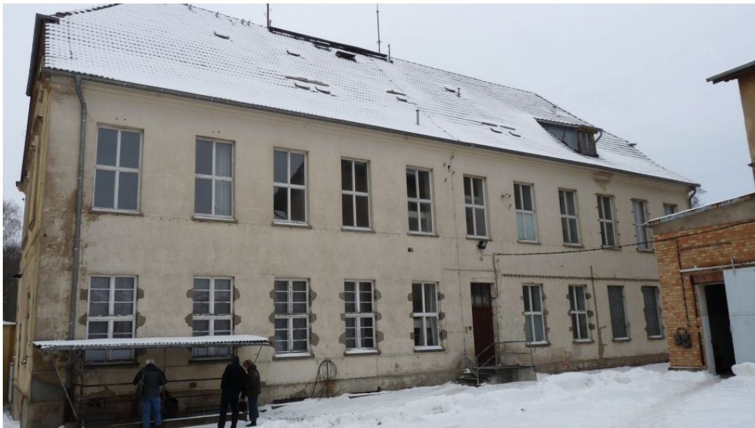
Abb. 2.3: Blick auf die Nordostfassade des Gebäudes im Frühjahr 2010
