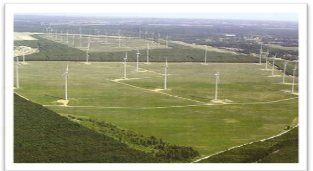
Abb. 11: Luftbild Windparkanlage Klettwitz
