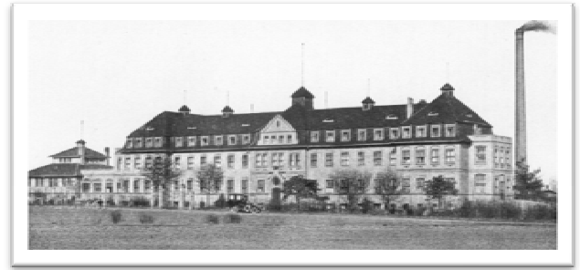
Abb. 18: Das Hauptgebäude nach der Erweiterung. Der hohe Schornstein besteht nicht mehr, ansonsten ist es unverändert geblieben
