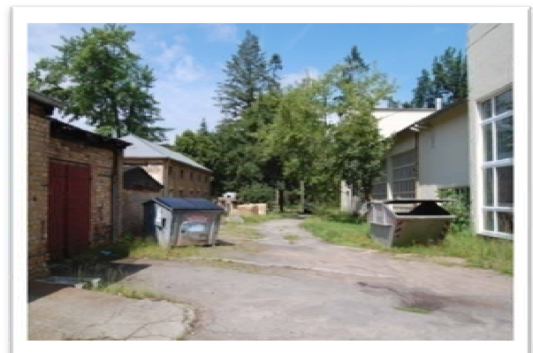
Abb. 42: Die linksseitigen Garagen sollen abgerissen werden. Rechts ist das Heizhaus
