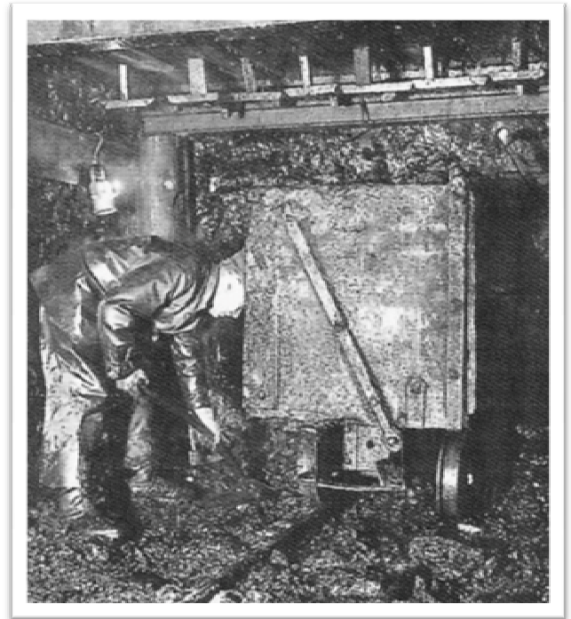
Abb. 5: Arbeit in einem Braunkohlenschacht
