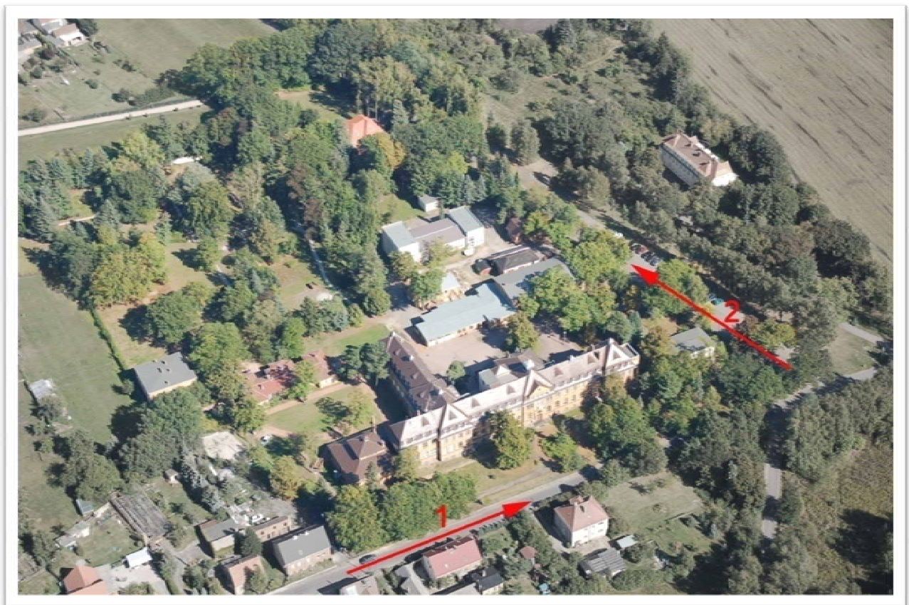
Abb. 23: Luftbild aus südlicher Richtung
