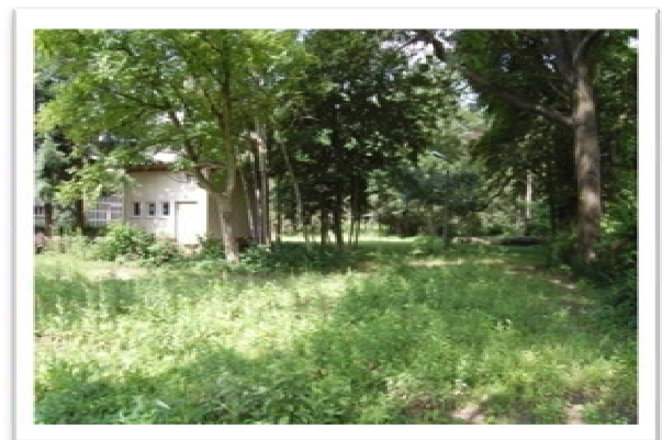
Abb. 40: Das Verteilerhaus mit Baumallee
