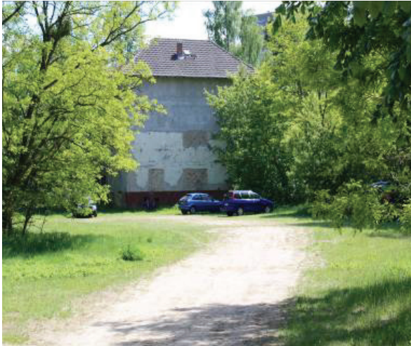
Abb. 26 Personalparkplatz Seehotel Templin C
