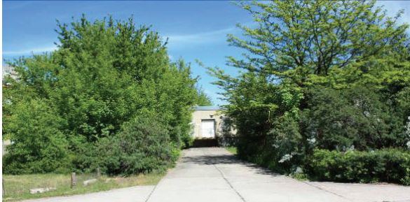
Abb. 35 Zufahrt zur Schwimmhallentechnik
