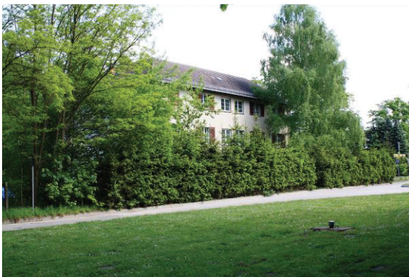
Abb. 27 Altes Wohngebäude neben Personalparkplatz
