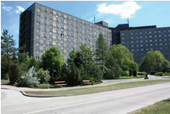
Abb. 29 Blick auf den Haupteingang des Seehotels Templin
