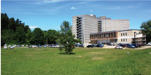
Abb. 33 Gästeparkplatz des Seehotels Templin gegenüber des Wirtschaftshofes
