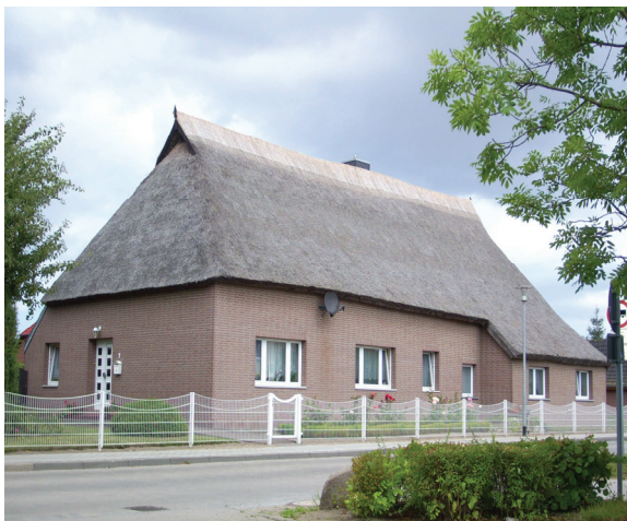
Abb.48: unpassende Einfriedung in Admannshagen (eigene Erhebung)
