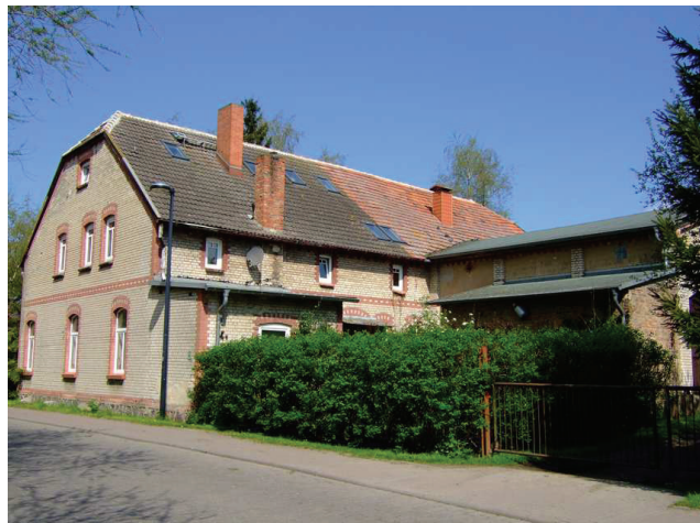
Abb. 20: Querhäuslerei in Biestow – 13 0 03 000/04 HAS (Quelle: eigene Erhebung)
