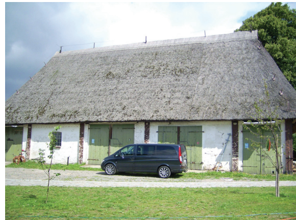
Abb. 36: umgebautes Niederdeutsches Hallenhaus in Biestow - 13 0 03 000/ 05 WRG (Quelle: eigene Erhebung)
