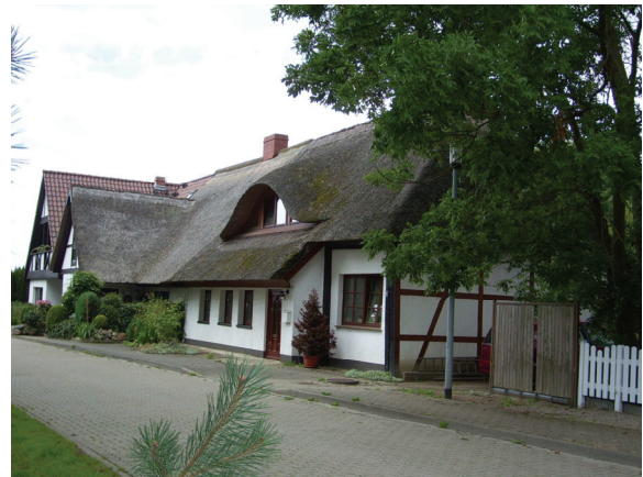
Abb. 27: stark verbautes Hallenhaus in Admannshagen - 13 0 51 001/06HAS (Quelle: eigene Erhebung)
