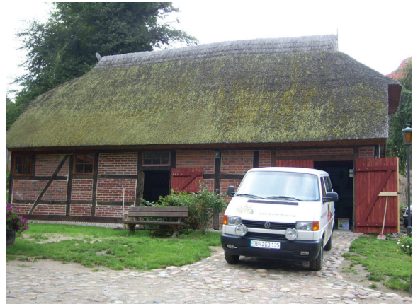
Abb. 47: ehemaliger Stall des Pfarrgehöfts Kessin - 13 0 51 035/ 07 WRG (Quelle: ebenda)
