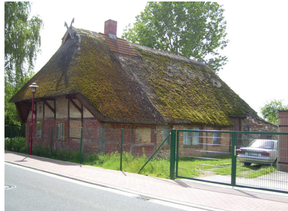
Abb. 30: Querdielenhaus in Sievershagen – 13 0 51 043/03 HAS (Quelle: eigen Erhebung)
