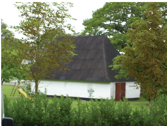
Abb. 44: Niederdeutsches Hallenhaus in Kessin - 13 0 51 035/ 04 WRG (Quelle: eigene Erhebung)
