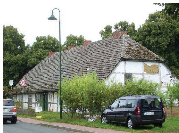
Abb. 43: umgebautes Niederdeutsche Hallenhaus in Kessin - 13 0 51 035/ 03 HAS (Quelle: ebenda)
