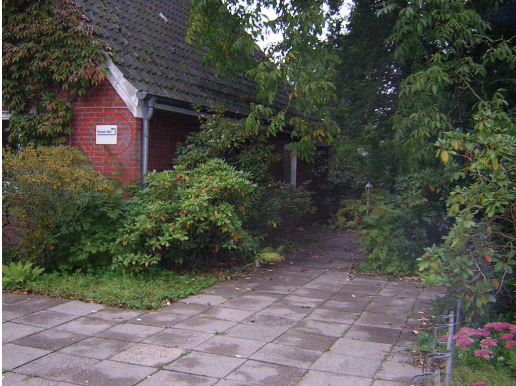
Abb. 14: Eingangsbereich zum Pfarramt / Gemeindebüro mit Blick auf das Hinweisschild an der Hausfassade (roter Kreis) Quelle: Eigene Aufnahme 2009
