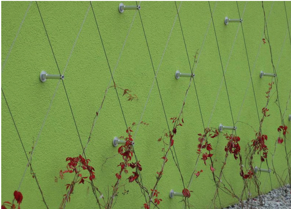
Abb. 21: Beispiel eines Seilsystems als Kletterhilfe, sowohl für die Pergola, als auch für die Gebäudefassade verwendbar.
