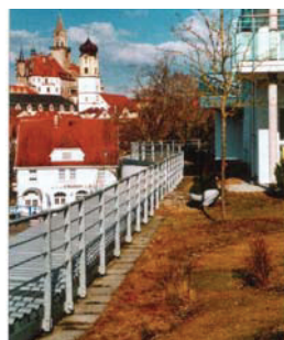
Abb. 40 : Permanente Absturzsicherung (Quelle: KOLB, 2003)
