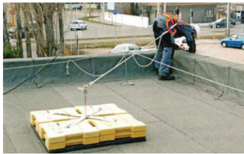
Abb. 38 : Wiederlager für Absturzsicherung (Quelle: DITTRICH 2008)
