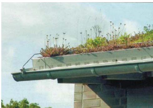
Abb. 43 : Geschlitztes Dachtraufprofil (Quelle: Appl 2004)
