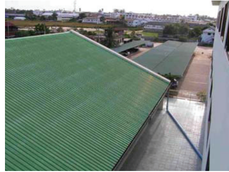
Abb. 22 : Schrägdach aus Stahlblech in Maha Sarakham
