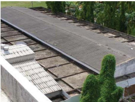
Abb. 23 : Schrägdach aus Faserzementplatten in Maha Sarakham
