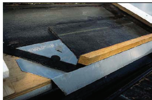
Abb. 46 : Schubschwelle und Dachabdichtung
