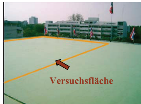
Abb. 50 : Dachfläche des Vorbaus (RMU)
