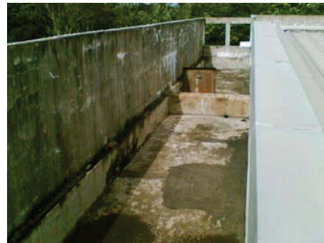
Abb. 24 : Endwässerungsrinne eines Schrägdaches in Bangkok
