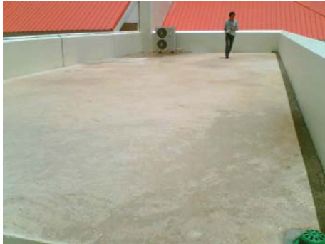
Abb. 72 : Dach der Fakultät für Architektur (MSU)
