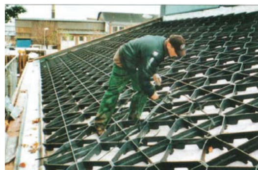
Abb. 44 : Georaster Elemente, (Quelle: Appl, 2004)
