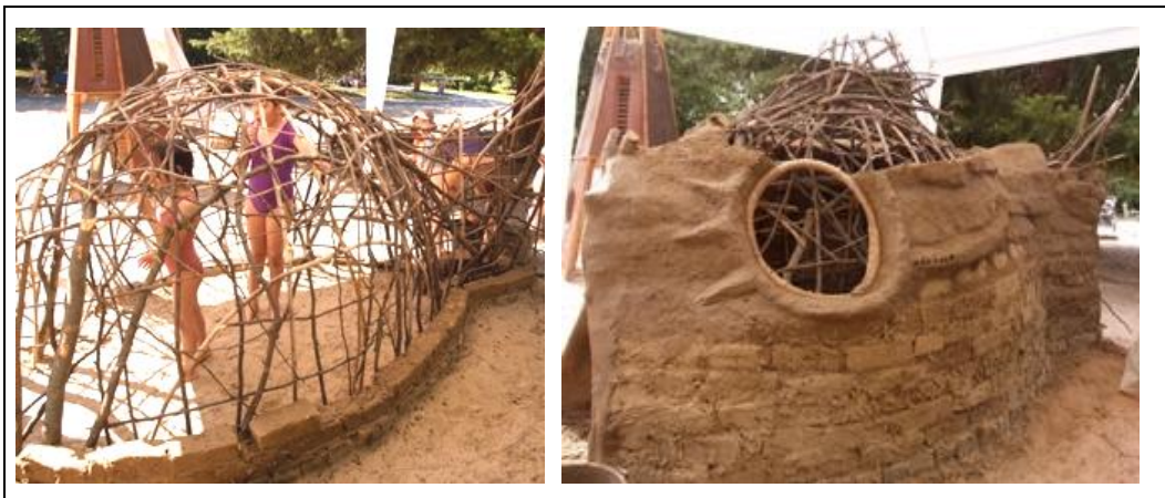
Abb. 3-3: Grundgerüst eines Fisches und die Herstellung der Außenhülle mit Lehmziegeln, das Verputzen und Modellieren von Strukturen erfolgt ebenfalls mit Lehm (Fotos von R. Warzecha)
