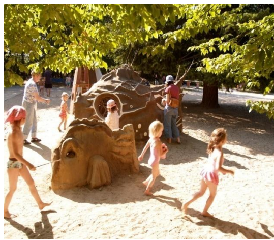
Abb. 4-5: die Lehmflächen werden mit Leinöl versiegelt (3. Foto von R. Warzecha)
