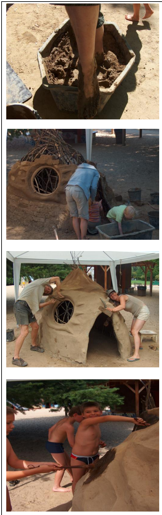
Abb. 4-4: das Verputzen der Lehmziegel
