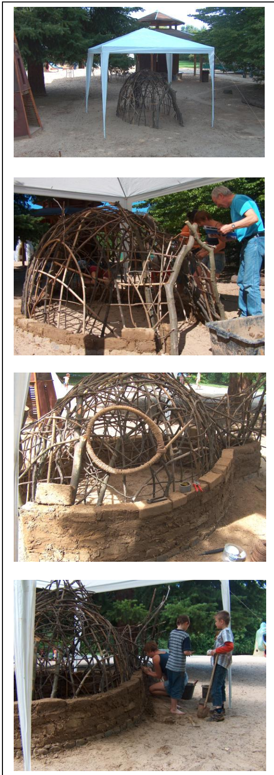
Abb. 4-3: fertiges Grundgerüst mit den ersten gesetzten Lehmziegelreihen
