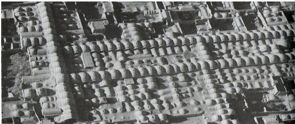
Abb. 2-2: Basar, Sedjan, Iran; (Gernot Minke, Lehm bau-Handbuch 1.Auflage1994, S.14)
