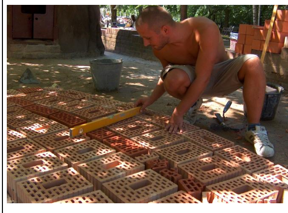
Abb. 4-9: die Couch wird aus Hohlblockziegeln gemauert
