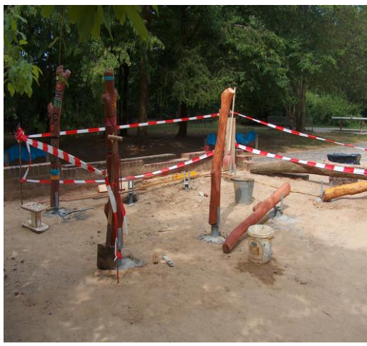
Abb. 4-18: die Holzpfeiler werden gesetzt
