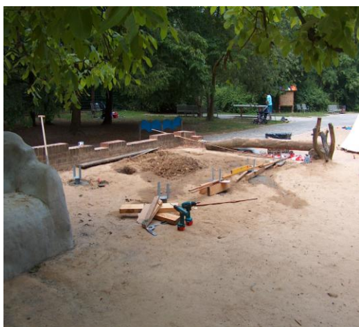
Abb. 4-17: Abstecken der Bühnen und das Setzen der Trägerpfosten
