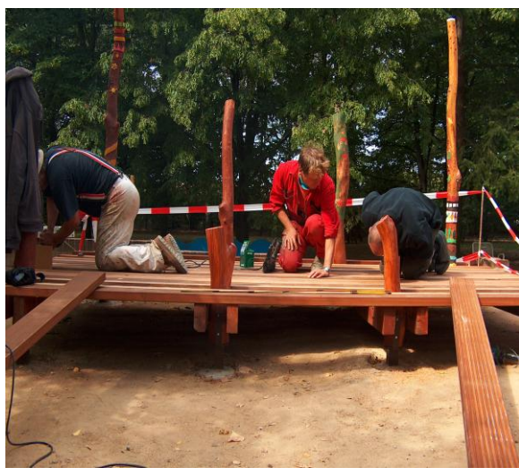
Abb. 4-19: Herstellung des Grundgerüsts und der Bühnenplattform
