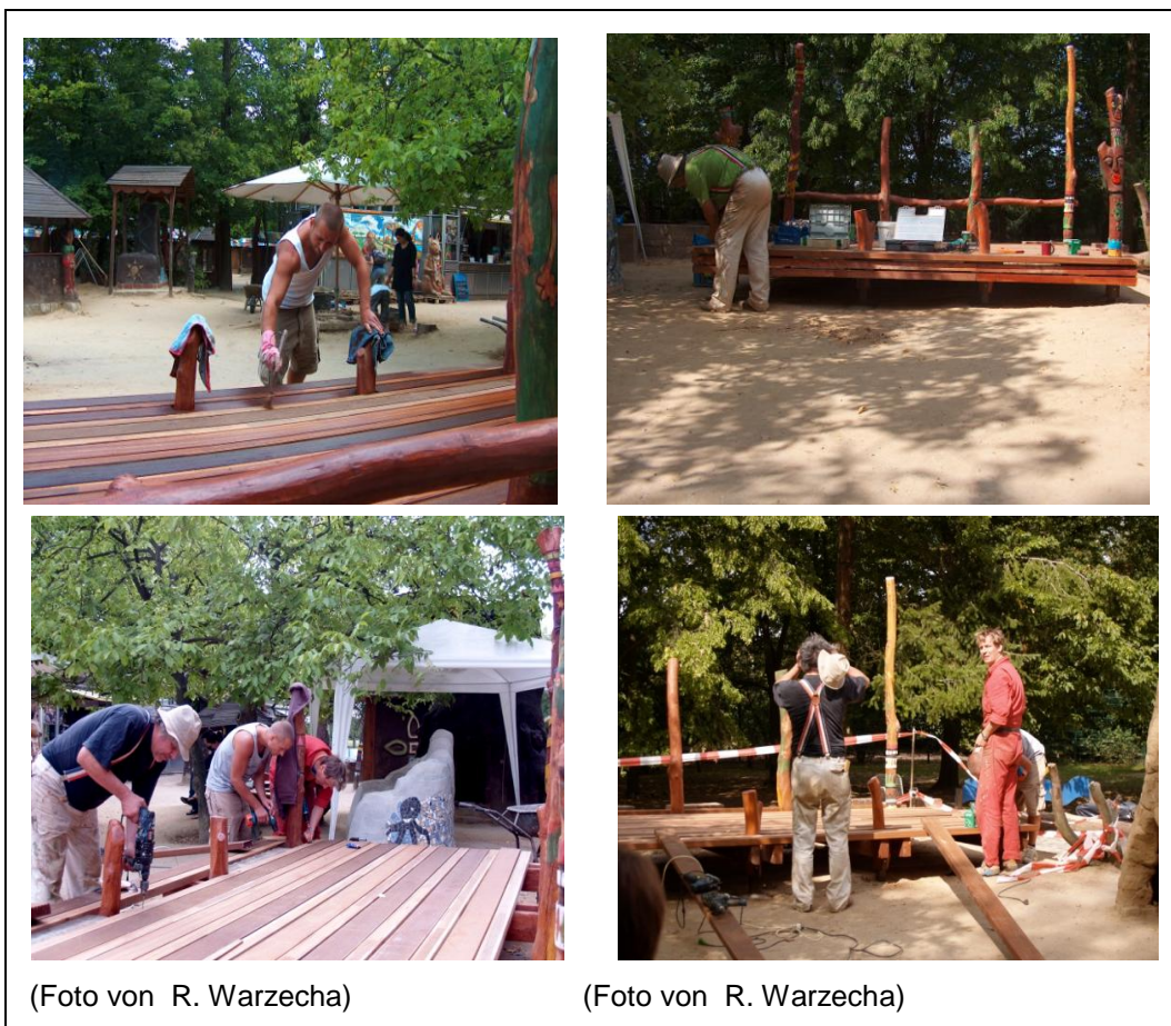
Abb. 4-20: Versiegelung der Hölzer und deren Verschraubung mit den Bodenhölzern
