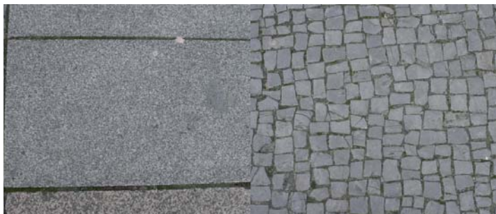
Abb. 7: Granitplatten und Basalt- Kleinsteinpflaster
