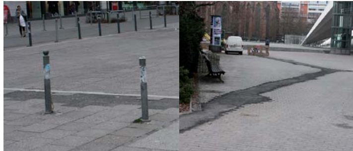
Abb. 5: Ausbesserungen defekter Stellen mit Asphalt
