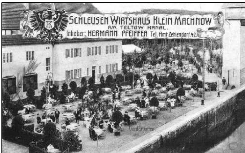
Abb.17: Schleusen-Wirtshaus „Pfeiffer“, um 1907
