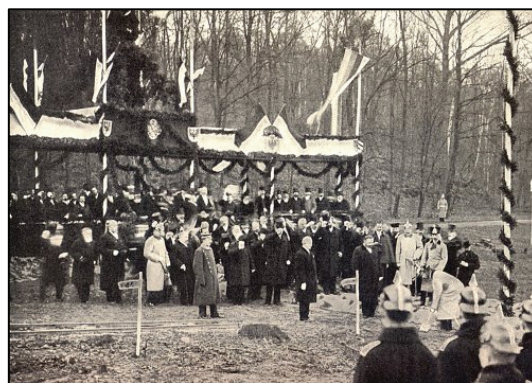
Abb.12: Erster Spatenstich am 22.12.1900
