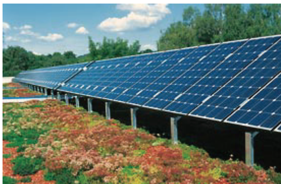
Abb. 44: Photovoltaikanlage auf extensiv begrünem Dach
