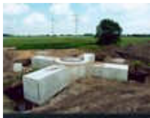
Abbildung 2-5 : kreuzförmiges Betonfundament, [27]
