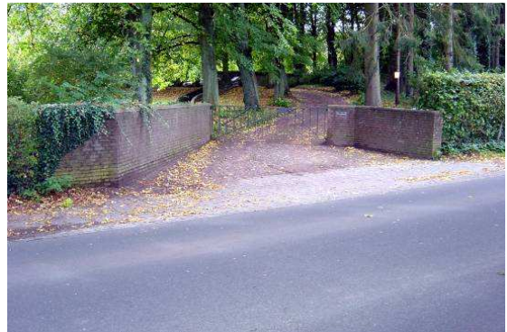
Abb. 53: Zugangstor Nr. 17 (Ki)
