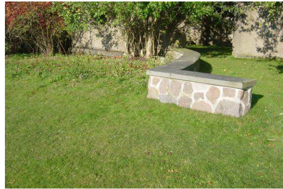
Abb. 94: Mauer vor dem Gartenhof (Ki)
