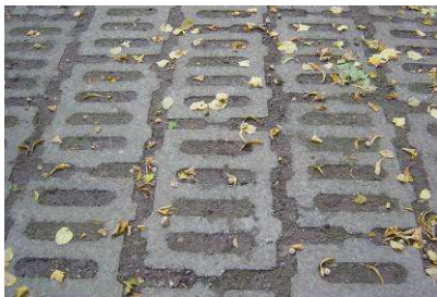
Abb. 55: Betonplatten der Parkfläche (Ki)
