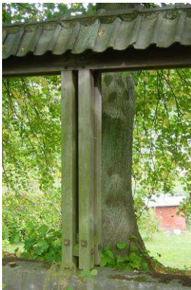
Abb. 89: Pfosten der Pergola (Ki)
