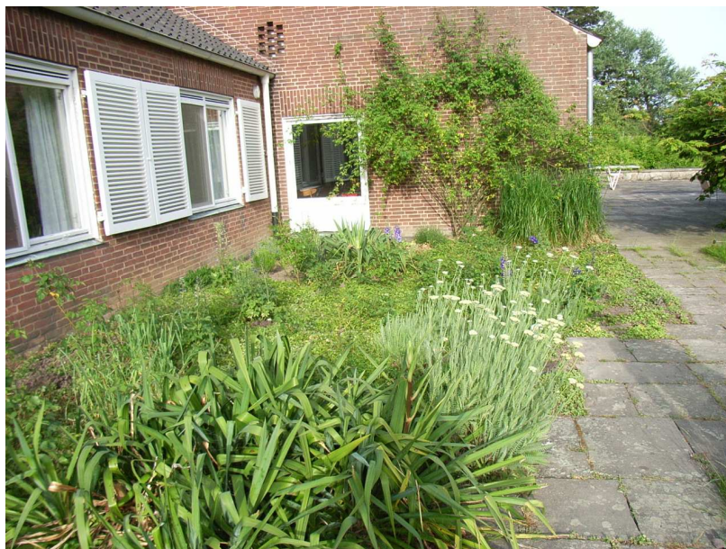
Abb. 100: Südwand des Landhauses – 2008 (Th)
