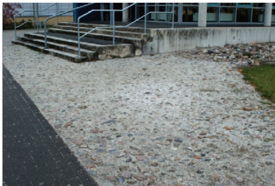
Abbildung 17: Aufnahme Ifd. Nr.: 1, Katzenkopfpflaster mit Splitt verfüllt
