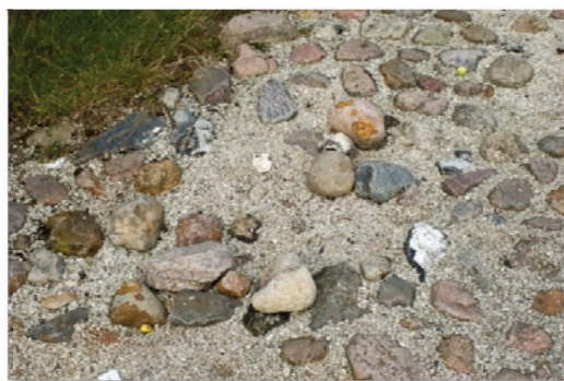
Abbildung 27: Katzenkopfpflaster am begleitenden Weg am Eingangsbereich
