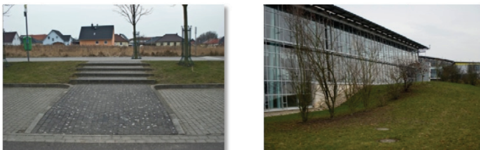
Abbildung 4: Böschung und Sporthalle am Parkplatz
