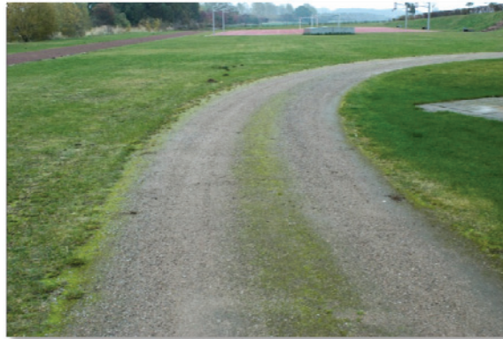
Abbildung 19: Aufnahme lfd. Nr.: 7, wassergebundene Wegedecke, „private Seite“
