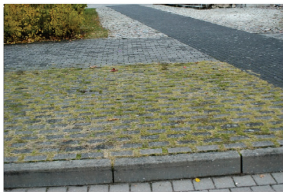
Abbildung 20: Aufnahme lfd. Nr.: 16, Rasenpflaster, Fahrradinseln
