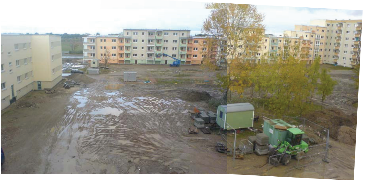
Abb.50: Innenhof Quartier A5 während der Umgestaltungsmaßnahmen (Hintergrund Abtrennung Gebäude) 165
