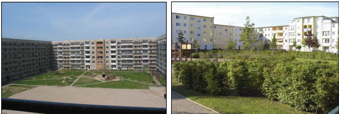
Abb.34: Quartier A4 Riemser Weg vorher und nachher 144
