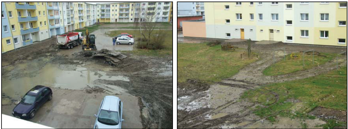
Abb.53: Innenhof vor der Umgestaltung (Baumbestand mittig bleibt, alte Spielgeräte werden abgebrochen) 175
