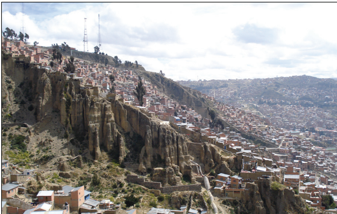
Abb. 3: Sicht von Barrio Lindo auf arme Wohnviertel des Bezirks Max Paredes, mit erosions-, abrutschgefährdeten Steilhängen und Blick auf die Einbruchkante des Altiplano. (eigenes Foto, aufgenommen von Barrio Lindo, 11.05.2009)
