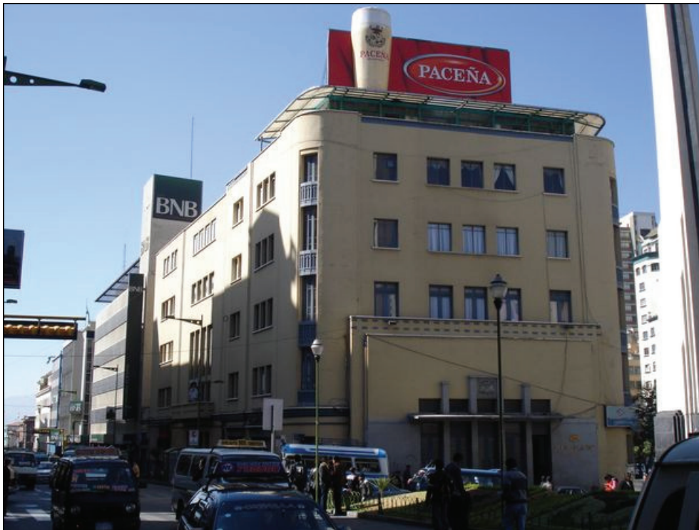
Abb. 32: Sicht von Norden auf das Gebäude „Club La Paz“ das als theoretisches Beispiel zu Naturation verwendet wird. Rechts vom Gebäude die Avenida Mariscal Santa Cruz, links die Camacho Strasse und im Vordergrund die Strasse Ayacucho. (eigenes Foto, 25.08.2009)
