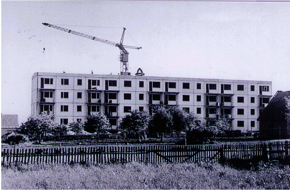
Abbildung 3: Baustelle 34- WE - Block
