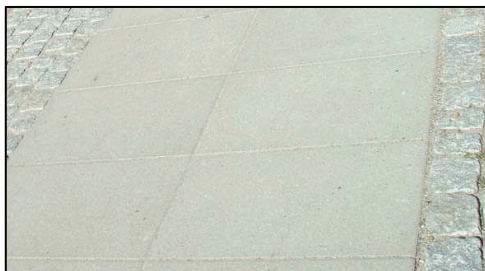
Abb. 22: Betongehwegplatten mit Natursteinkleinpflaster (Quelle: FÖRSTE, 2009)
