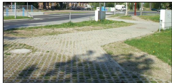
Abb. 23: Weg aus Rasengittersteinen mit Schaltschränken (Quelle: FÖRSTE, 2009)
