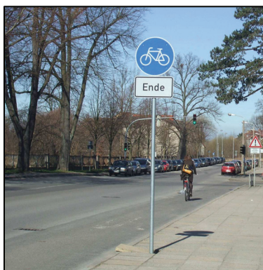
Abb. 26: Ende des Radweges mitten auf der Fahrbahn (Quelle: FÖRSTE, 2009)
