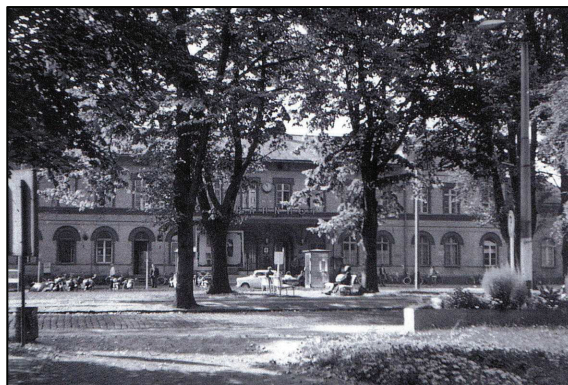
Abb. 2: Bahnhofsgebäude mit Vorplatz, Foto: 1975 (Quelle: GRUSENICK, D. 2008: 12)
