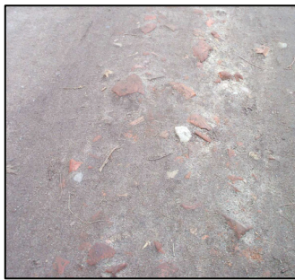
Abb. 20: Unterbau aus Ziegelbruch vom Wallweg (Quelle: FÖRSTE, 2009)
