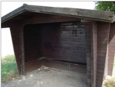
Abb. 75: Bushaltestellenhaus in Stolpe
