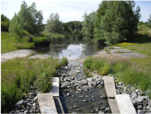
Abb. 6: Auslauf in den Sandfang
