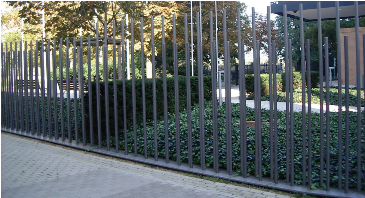
Abbildung 56: Zaun im Bereich des „Langen Eugen“
