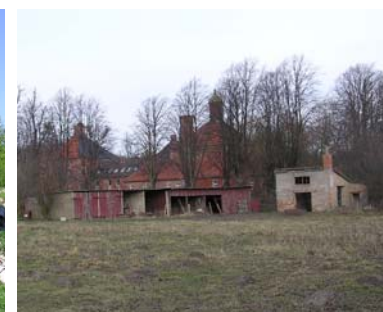
weitere Bestandsgebäude am Eingangsbereich
