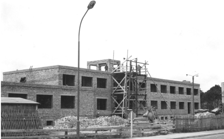
Abb. 6. Poliklinik im Rohbau
