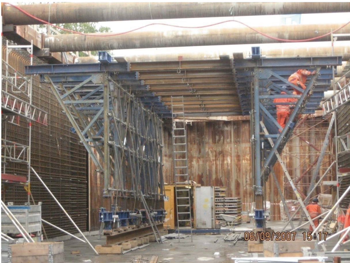
Abb. 6: Schalwagen beim Aufbau
