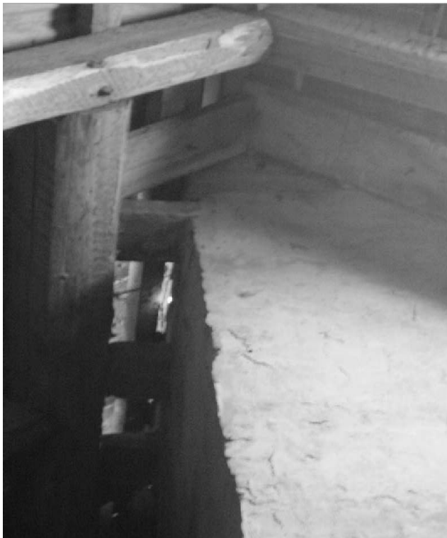
Abb.: 28 Anschluss Schornstein
