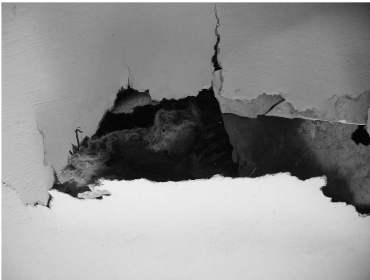
Abb.: 30 Deckendurchbruch Dachkammern
