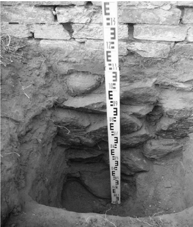
Abb.: 08 Fundament Südwest
