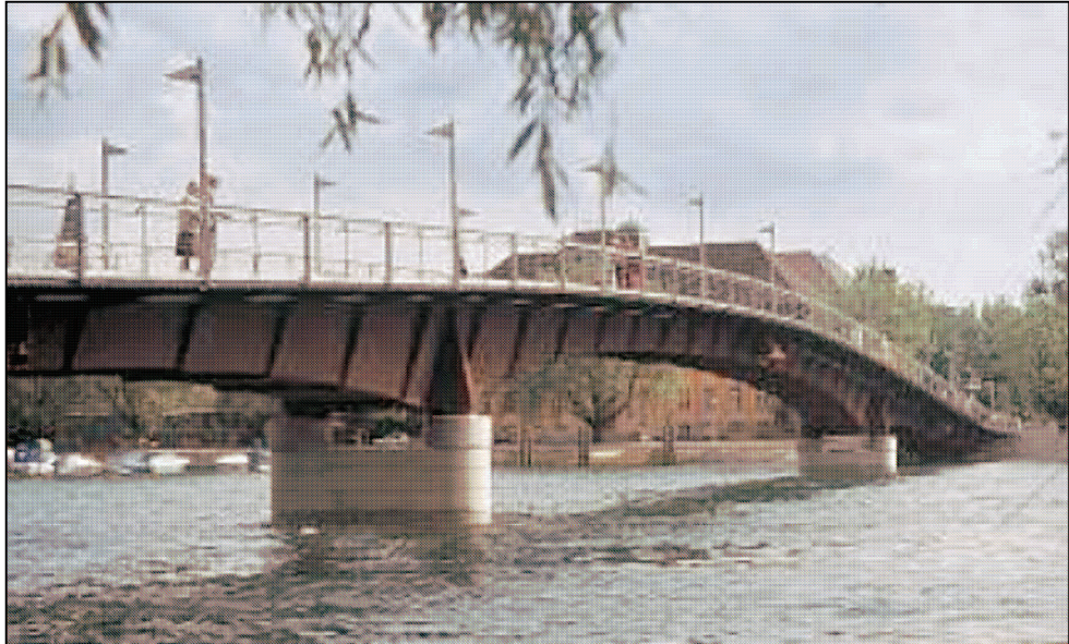
Abb. 26: Fußgänger- und Radfahrerbrücke über den Seerhein in Konstanz nach [B26]
