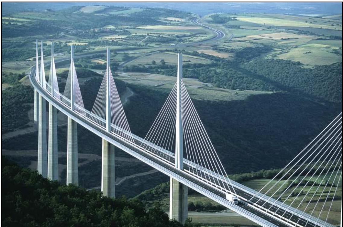
Bild 30: Viadukt von Millau nach [B30]
