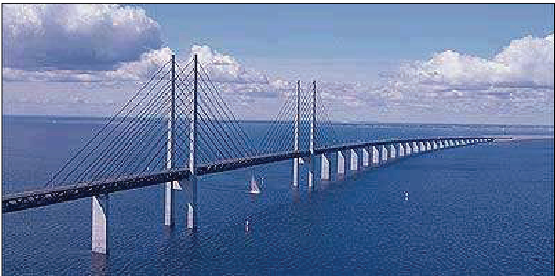
Abb. 22: Öresund- Viadukt, Hauptbrücke nach [B22]
