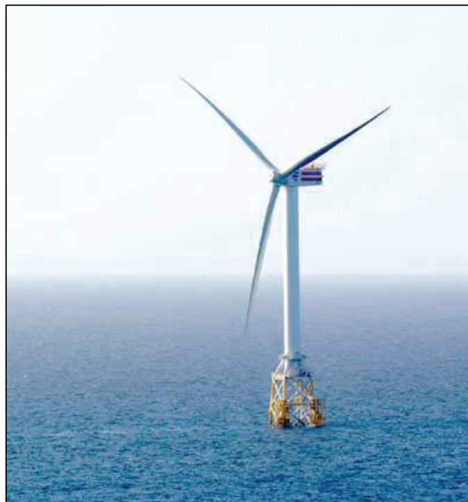
Abb. 35: OWEA „REpower 5M“ mit Jacket-Tragstruktur nach [B35]
