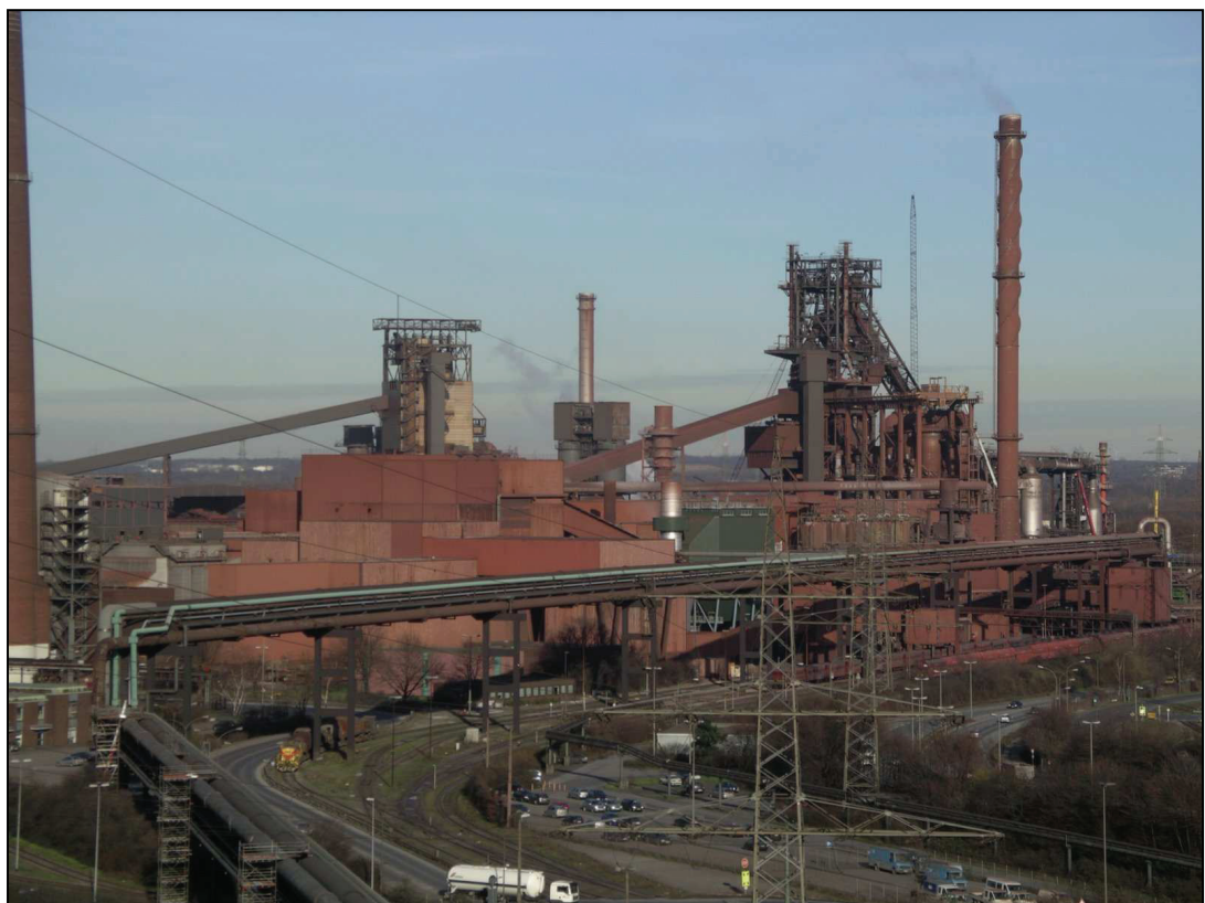
Abb. 1: Sinteranlage und Hochofen 1 in Duisburg-Schwegeln nach [B1]
