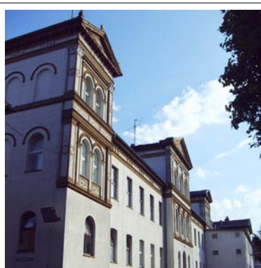
Abb. 11, Haus A, Haupthaus, Frontansicht
