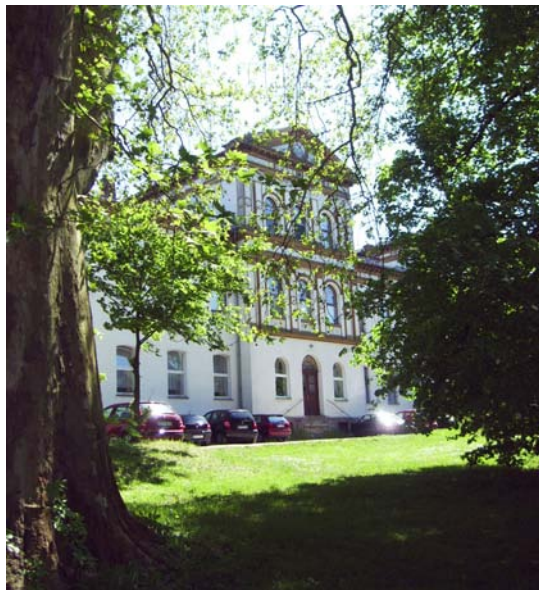
Abb. 2, Frontansicht DRK Krankenhaus Neustrelitz
