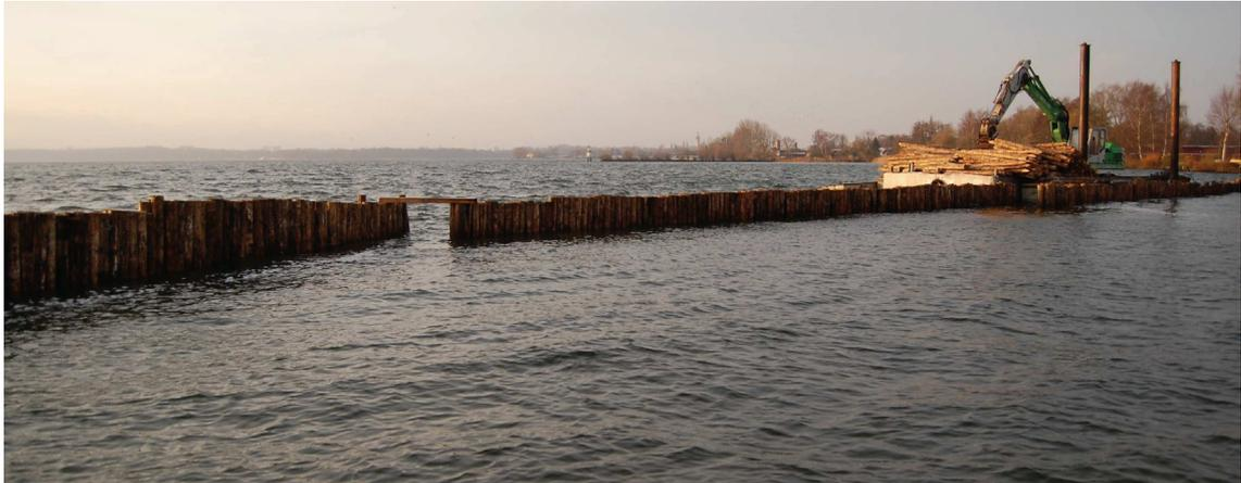
Abb. 2: Bau der Palisade im Januar 2008 (Foto: UNB SN)
