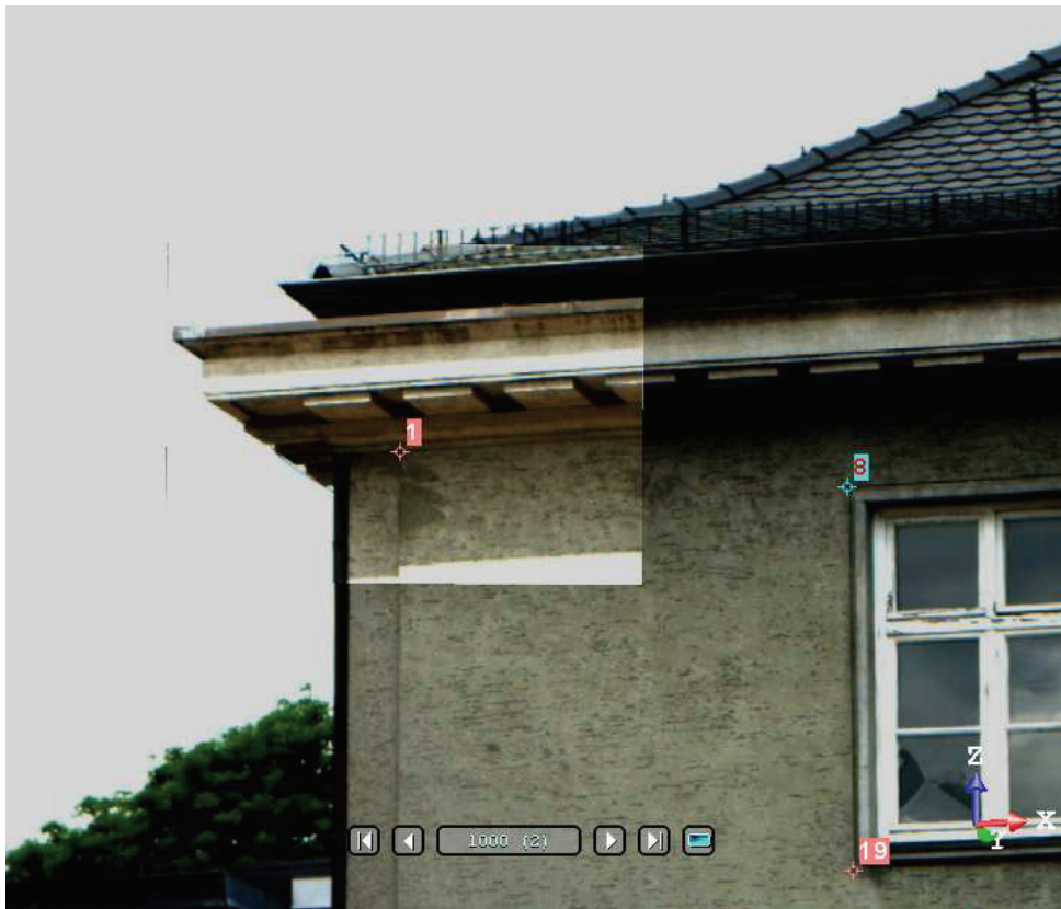
Abbildung A.7: linke obere Ecke der Fassade mit gemessenen Punkten
