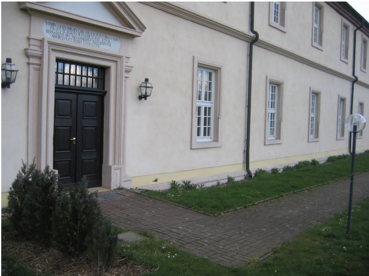
Abb. 36: Portal des Südflügels, Material der Wege, Beleuchtungsausstattung, Neuanpflanzungen widerstreben völlig dem Charakter der baulichen Anlage; unbegründetes Ende des Weges
