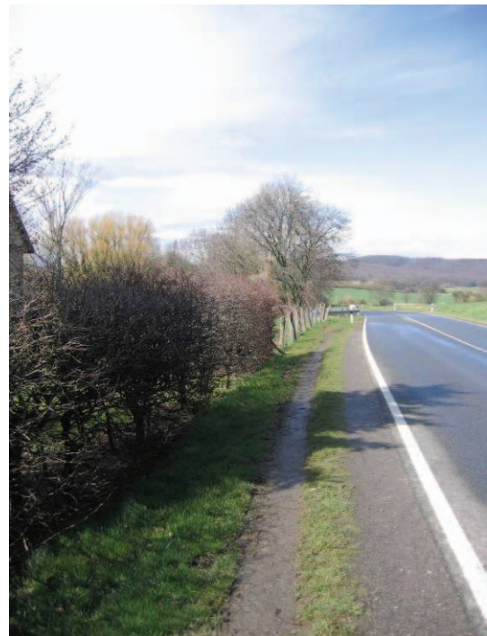
Abb. 37: Schmäler abschüssiger Grat für Fußgänger, Radfahrer und Pferde entlang der Kreisstraße 1
