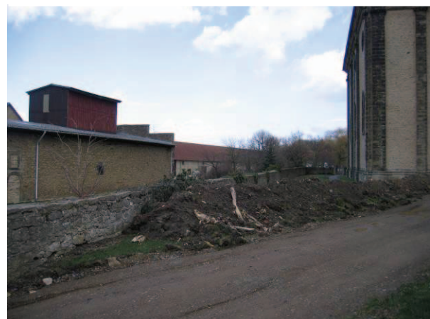
Abb. 28: Kirchhof, derzeit Baustelle, Kirchmauer fängt an dieser Stelle einen Geländeunterschied zum Kirchhof von einem Meter auf
