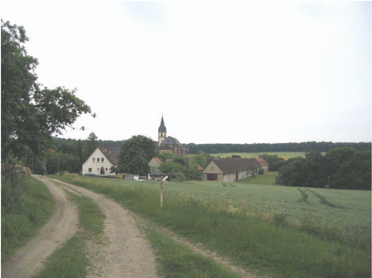
Abb. 30: Blick vom Windmühlenberg über das Gut Grauhof, im Hintergrund liegt der Grauhöfer Holz, dahinter Goslar
