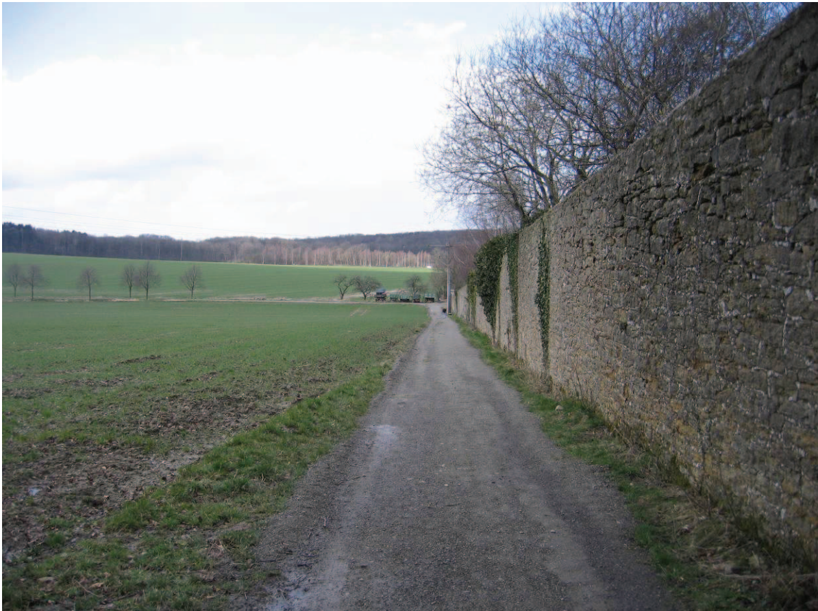
Abb. 16 Bruchsteinmauer, umläuft das gesamte Ensemble, drei bis vier Meter hoch, Westseite
