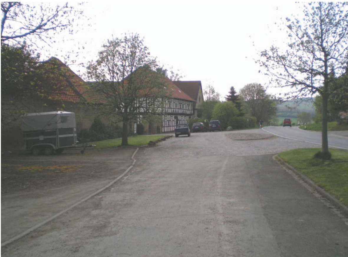
Abb. 39: „Unsortierte“ Freiflächengestaltung zwischen Kreisstraße und Denkmalensemble, schlechte Ausbildung der eigentlichen Gutszufahrt
