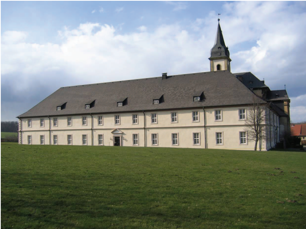
Abb. 14: Ehemaliges Konventsgebäude, Südseite
