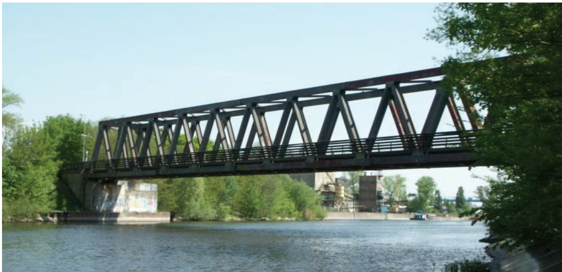
Abbildung 1: Alte Roskower Eisenbahnbrücke
