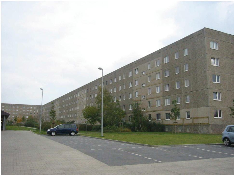
Abb. 3: Gebäudezeile Typ WBS70
