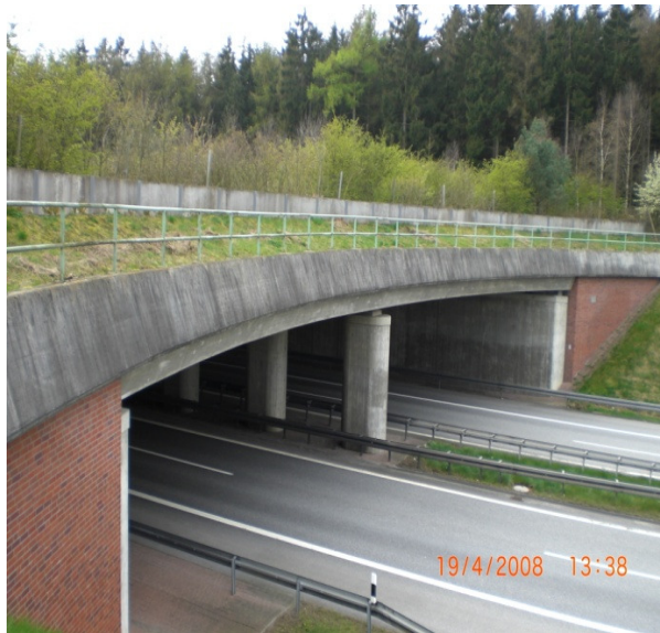
Abb-5.5: Brücke Beidendorf [T.Pfeifer]
