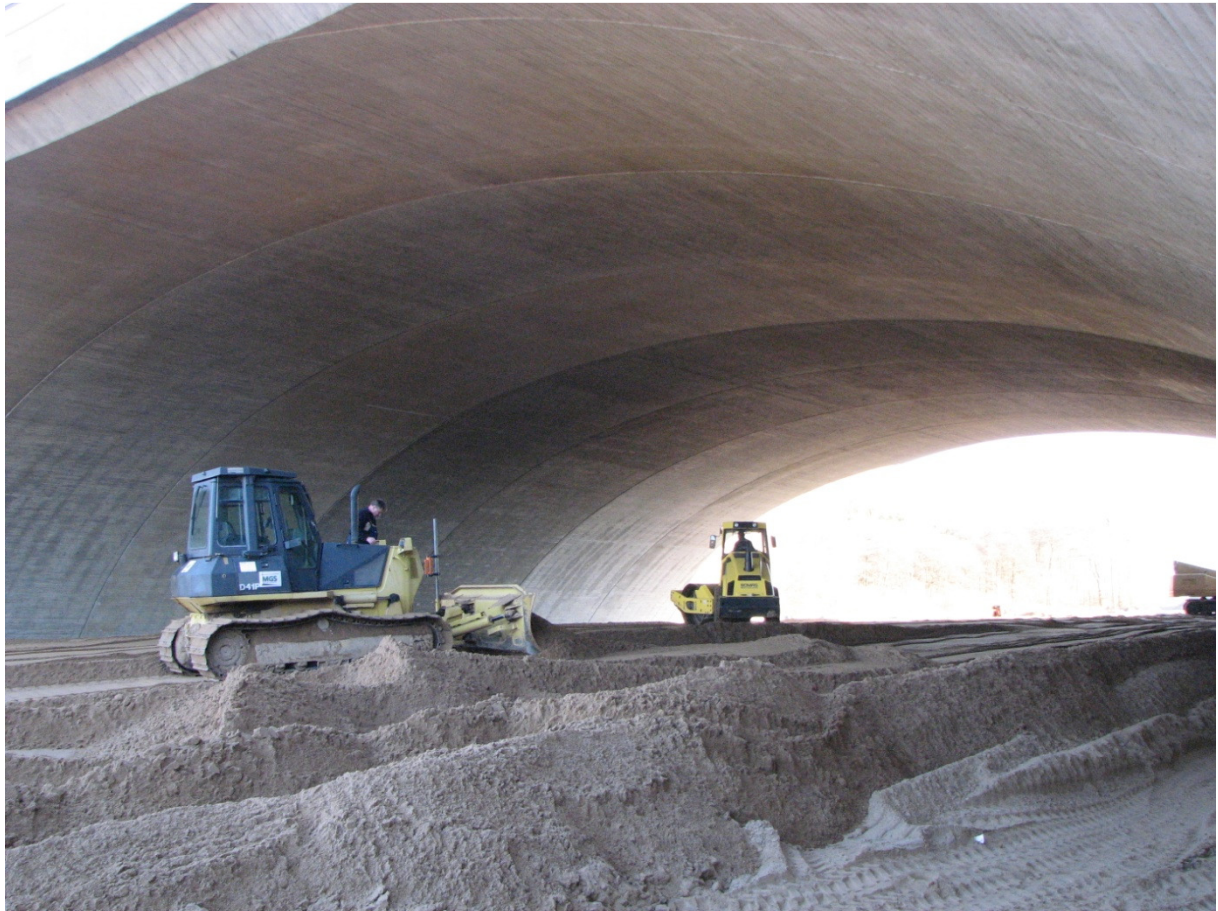
Abb-5.21: Sichtbarkeit der Betonierabschnitte [Ingenieurbüro Schwesig + Lindschulte]
