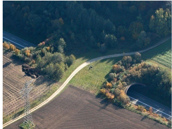
Abb-5.23 : Grünbrücke Hirschweg B31neu [ CD-FSS Heft 971]
