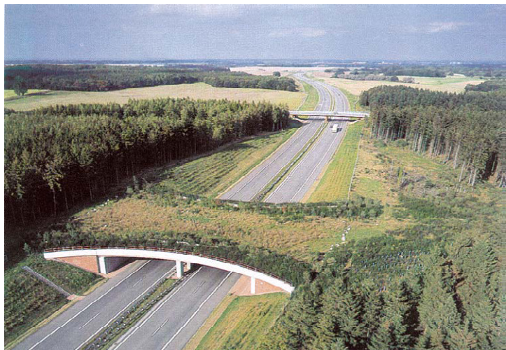
Abb-2.12: Grün- und Wildbrücke bei Beidendorf [ CD-FSS Heft 971]
