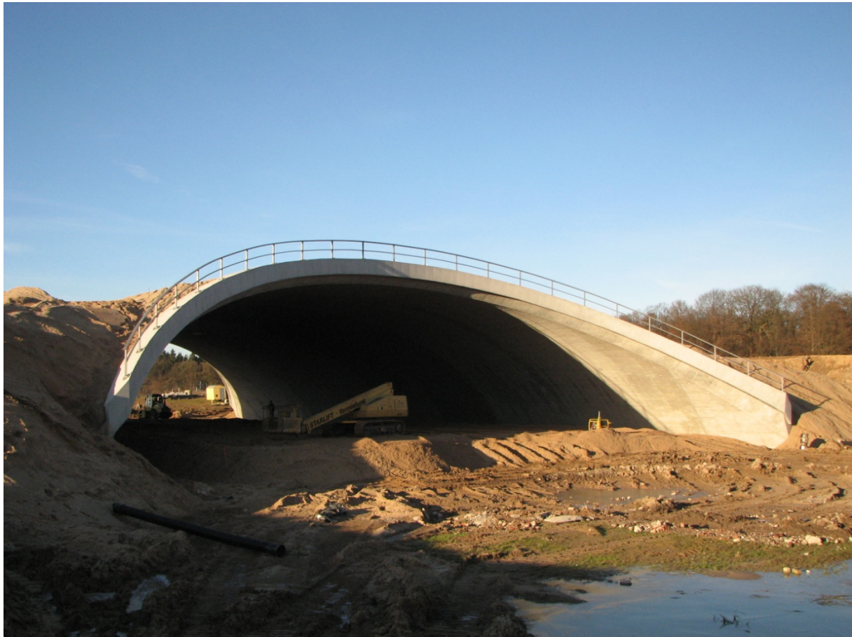
Abb-5.20: Grün-und Wildbrücke Hainholz [Ingenieurbüro Schwesig + Lindschulte]
