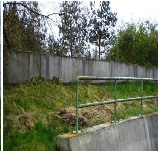
Abb-2.4: Lärmschutzwand Beton auf Wall 0,9m hoch [Foto T.Pfeifer]
