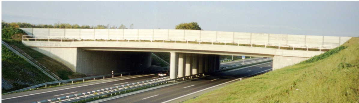
Abb-5.13: Grün- und Wildbrücke bei Vietow [Ingenieurbüro Schwesig + Lindschulte]
