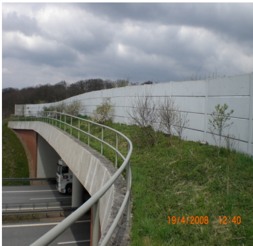
Abb-2.3: Lärmschutzwand Beton 2,1m hoch [Foto T.Pfeifer]
