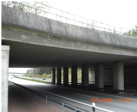
Abb-5.6: Brücke Beidendorf [T.Pfeifer]
