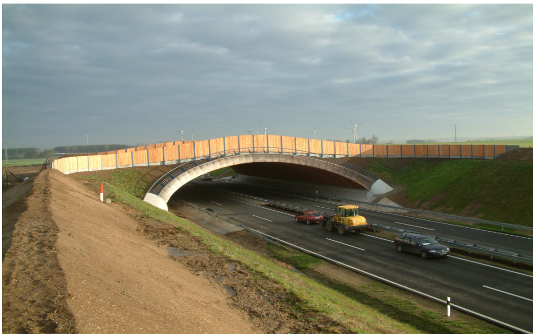
Abb-2.5: Foto Lärmschutzwand aus Holz mit anschließendem Erdwall [Ingenieurbüro Schwesig + Lindschulte]
