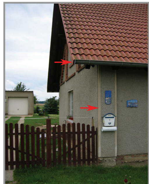
Abb. 4.4: Aufnahme der Gebäude und Dachpunkte
