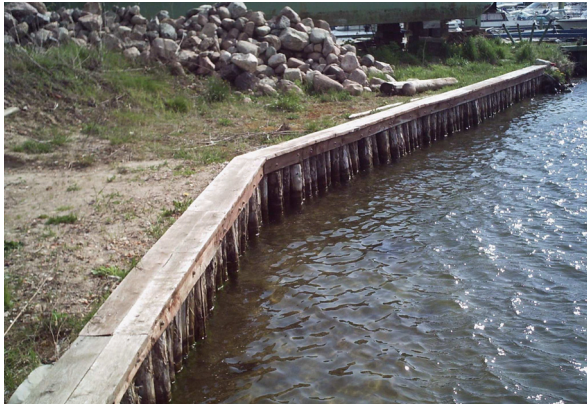
Abb.27: fertige Lärchenholzspundwand
