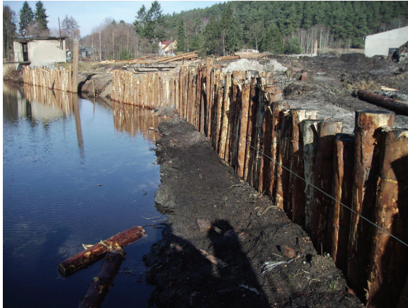
Abb.17: unfertige Spundwand
