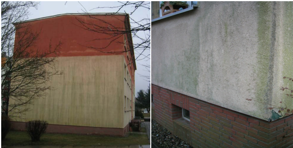
Abbildung 1: Algenbefälle an Fassaden
