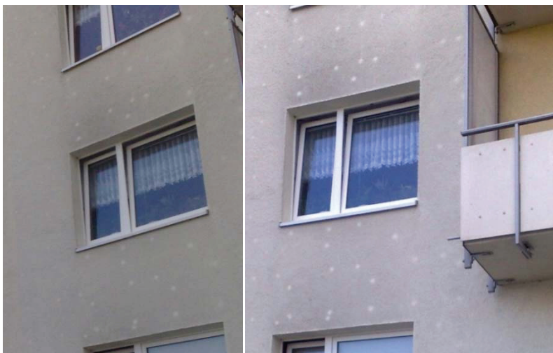
Abbildung 2: Leopard-Effekt an einer Fassade in der Neustrelitzer Str. 27 in Neubrandenburg
