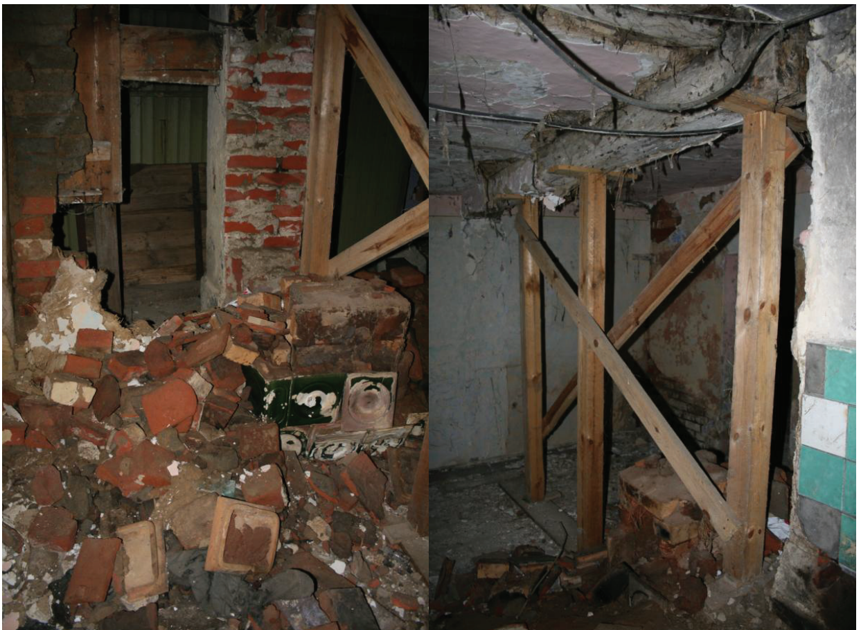
Abbildung 18: Sicherungsbalken im Fischerhaus, Begehung am 10. Januar 2018 (MAMEROW 2018)
