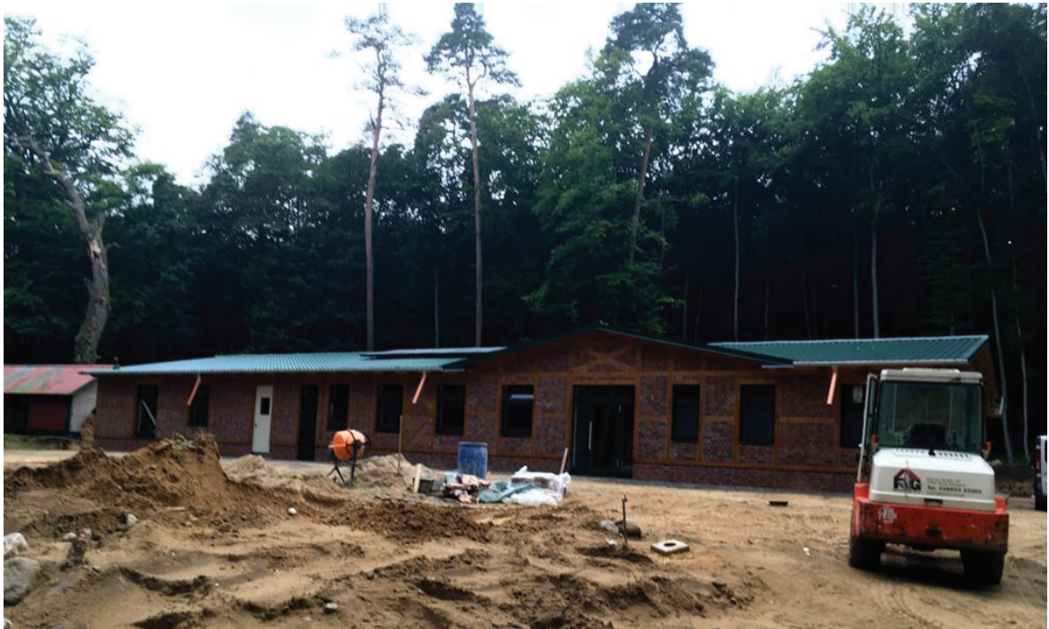
Abbildung 16: Das neue Wirtschaftsgebäude des Tiergarten Neustrelitz wird errichtet.
