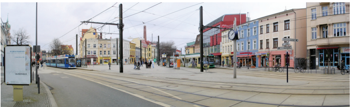
Abbildung 30: Oberleitungen Doberaner Platz
