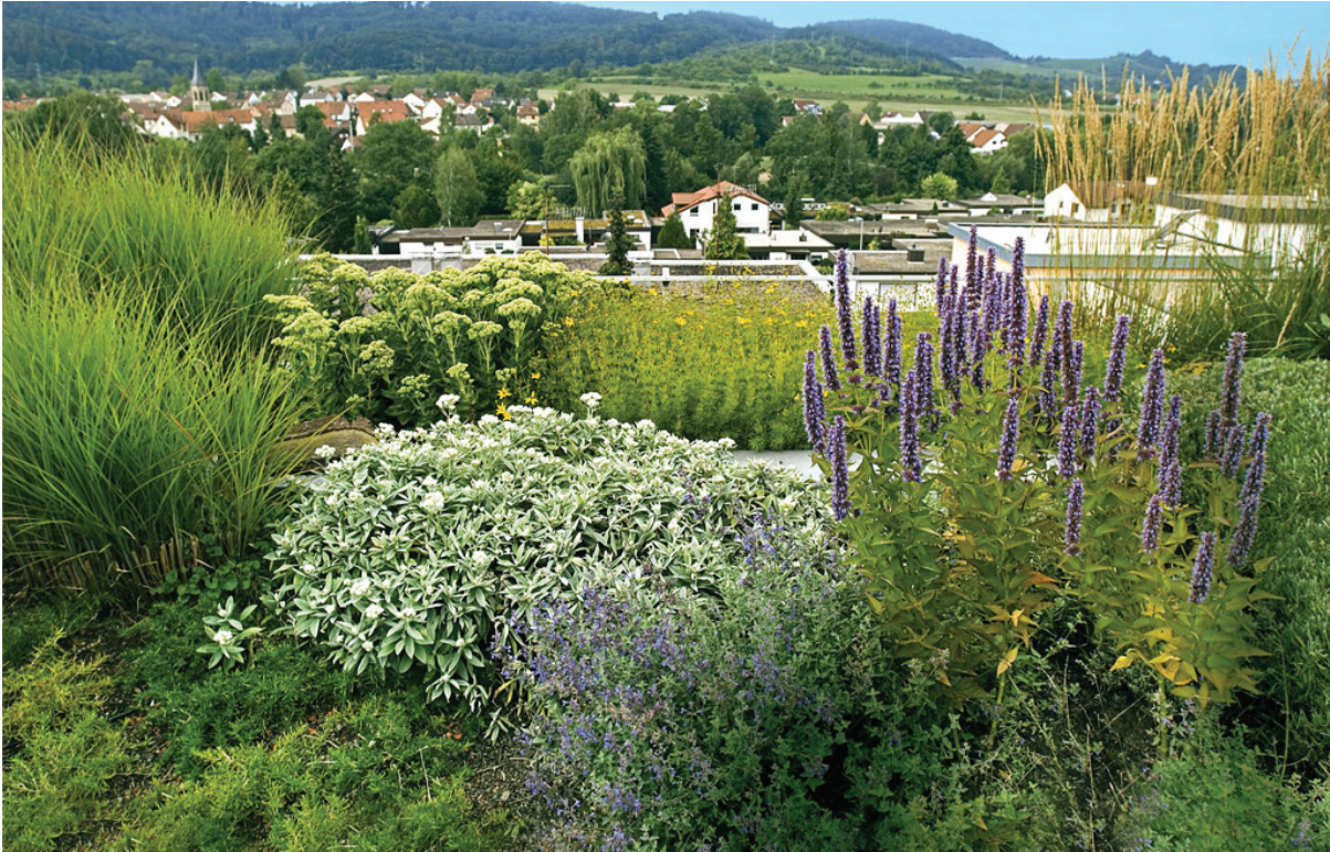
Abbildung 42: intensive Dachbegrünung auf einem Wohnhaus
