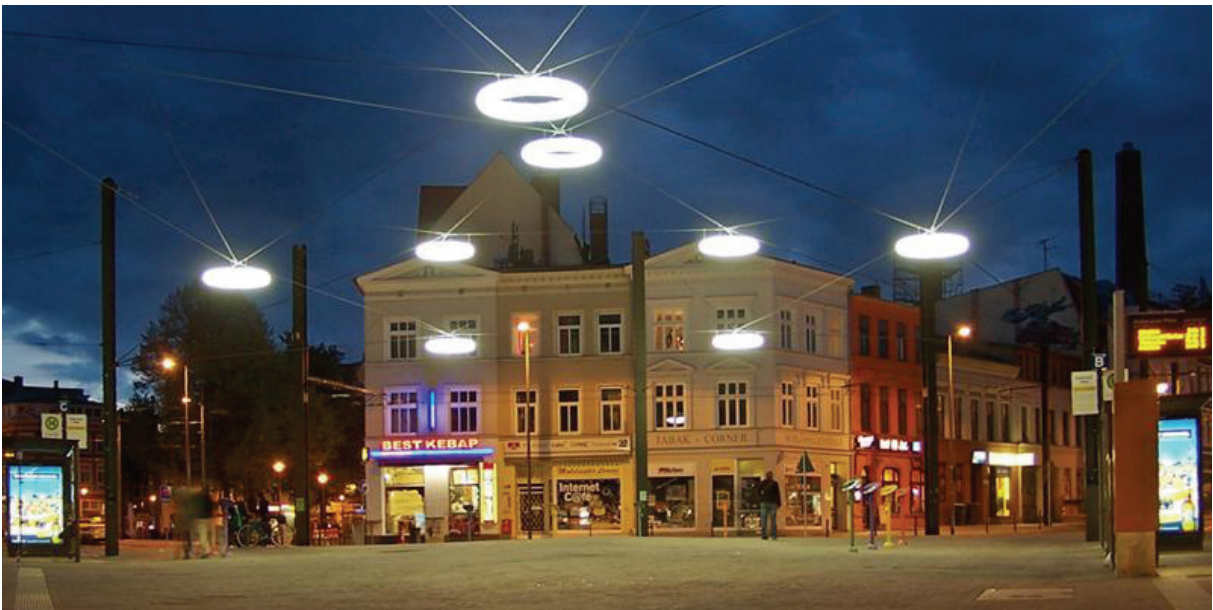
Abbildung 29: Oberleitungen mit Beleuchtung
