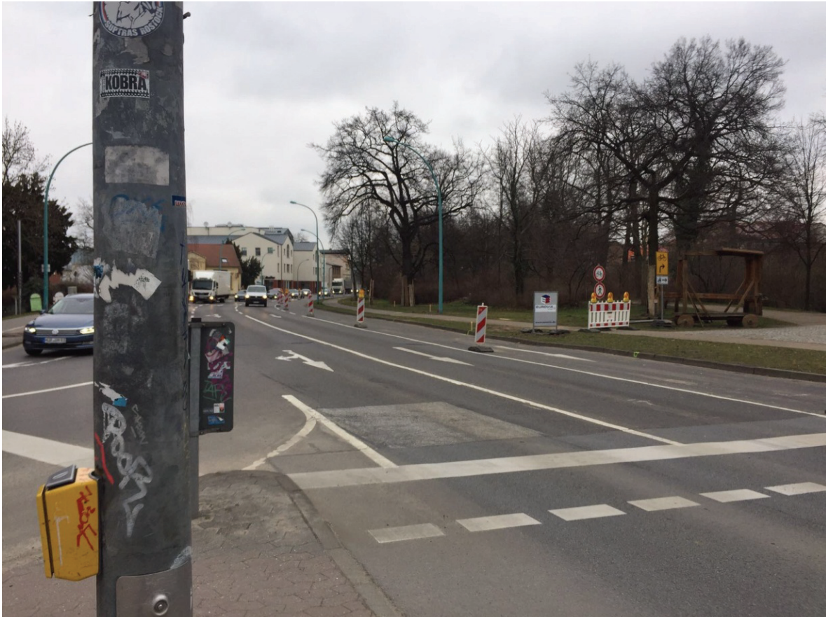
Abbildung 72: Situation während Baustellenphase auf dem Ring
