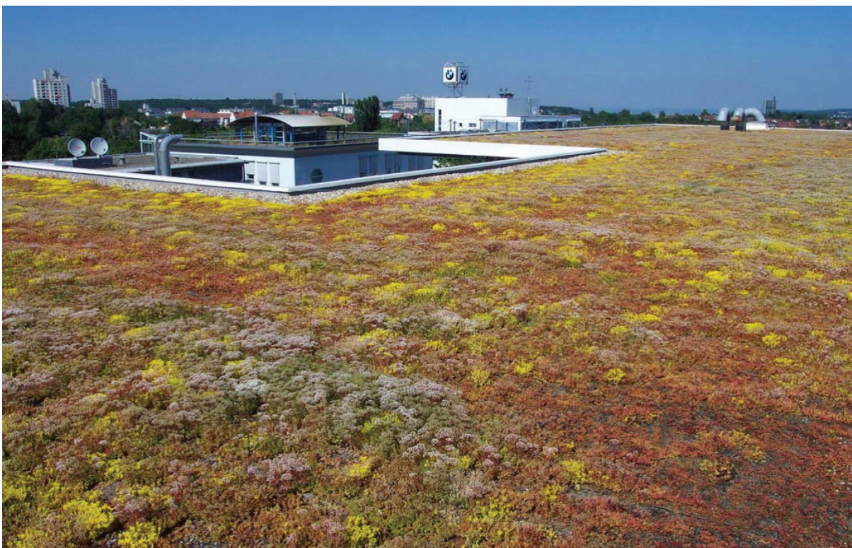
Abbildung 40: Extensive Dachbegrünung auf einem Flachdach
