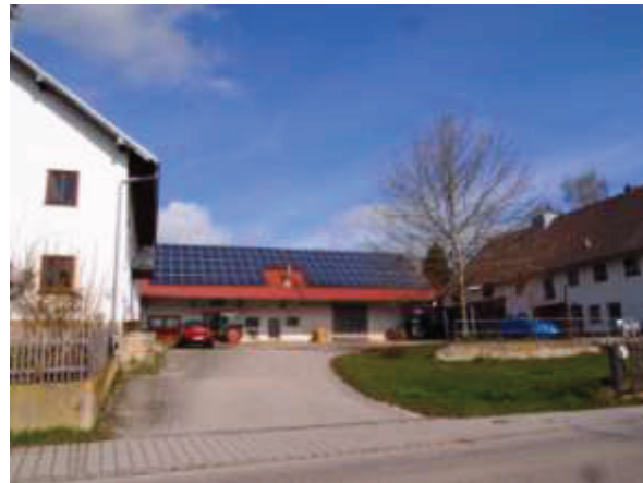
Abbildung 51: Landwirtschaftlicher Hofbetrieb an der Freisinger Straße (nördlich), Marzling
