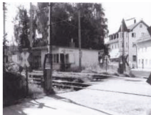
Abbildung 97: Bahnhof Marzling kurz vor seiner Schließung 2007
