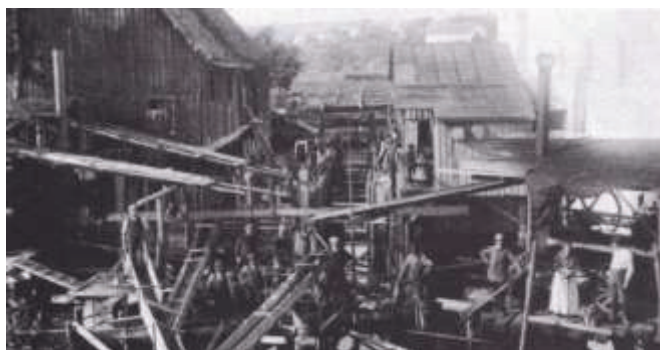
Abbildung 63: Einbau von zwei Turbinen 1910
