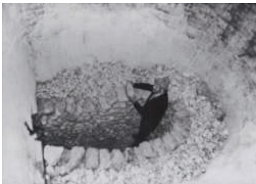
Abbildung 10: Aufschichten von Kalksteinen in den Ofen, Tölz
