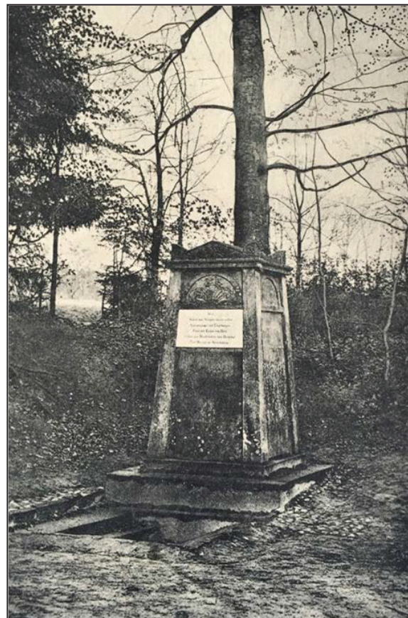
Abb. 51 Links und rechts der Stufen ist die nachträgliche Befestigung mit Pflastersteinen zu sehen. Undatierte Photographie.
