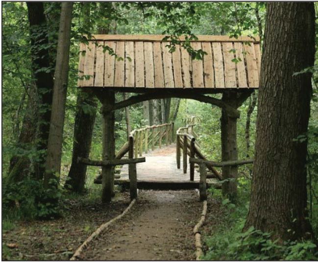
Abb. 62 Ein Bild aus besseren Tagen. Einladend zur weiteren Erkundung wirkte der Zugangsbereich zum Steig mit überdachtem Holzportal.
