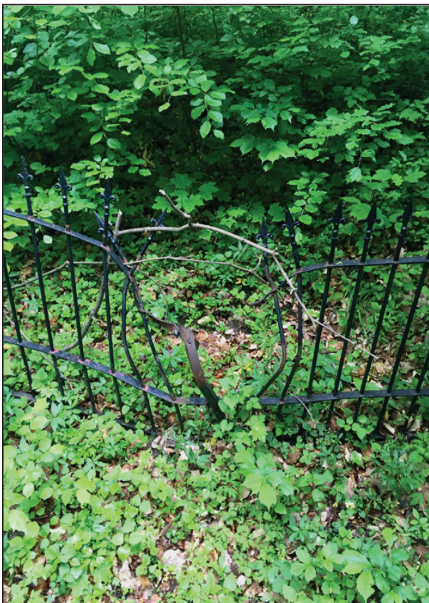
Abb. 54 Ein beschädigtes Zaunfeld auf der linken Seite (in Blickrichtung zum Stein) der Einfriedung.
