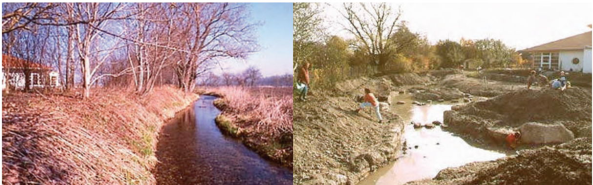
Abb. 52 Der Fehlbach vor der Umgestaltung – Modellierung des Baches
