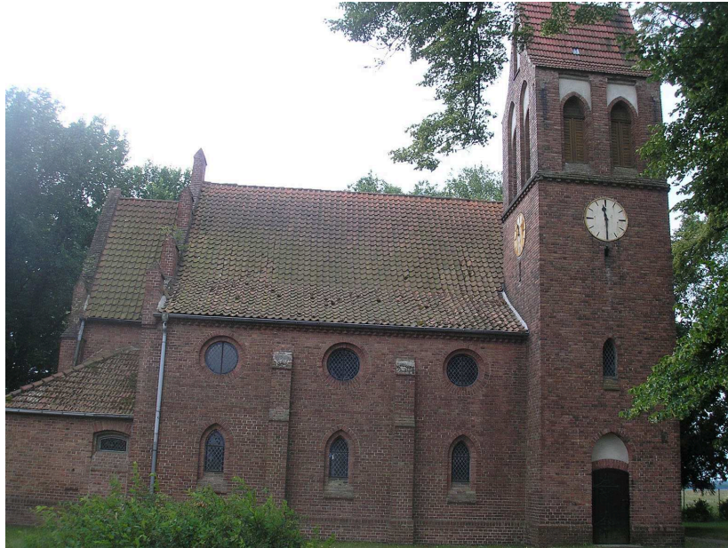
Abb. 5.14: Ziegelstein-Kirche im Ortsteil Kappe Foto: Franziska Behrens
