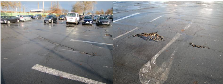
Abb.24: Schaden im Asphalt, unterliegendes Pflaster zu sehen
