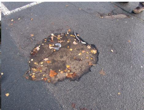
Abb.48: Beschädigte Asphaltoberfläche
