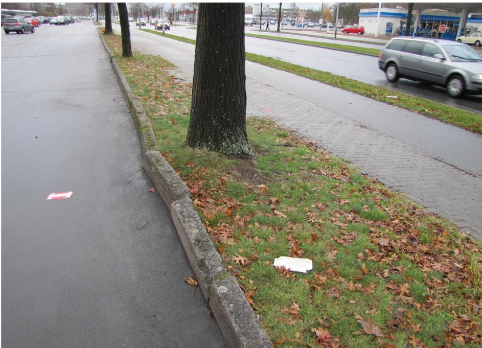
Abb.46: Bordsteinbeschädigung durch Baumwurzeln
