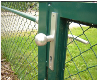
Abbildung 27: von innen nicht zu öffnender Türknauf im Garten des Pflegeheims: An der Beeke in Schwaan, Quelle: eigene Erhebung 23.08.2010
